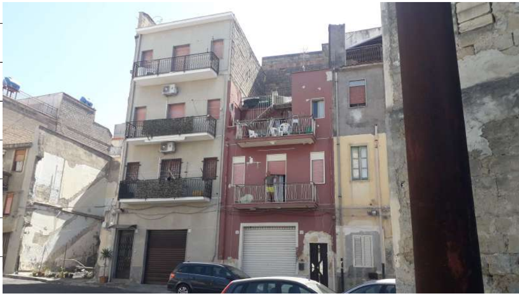
Foto n.2: immagine esterna dell'edificio sito in via Sassari nn.15 e 17 a Lentini.
