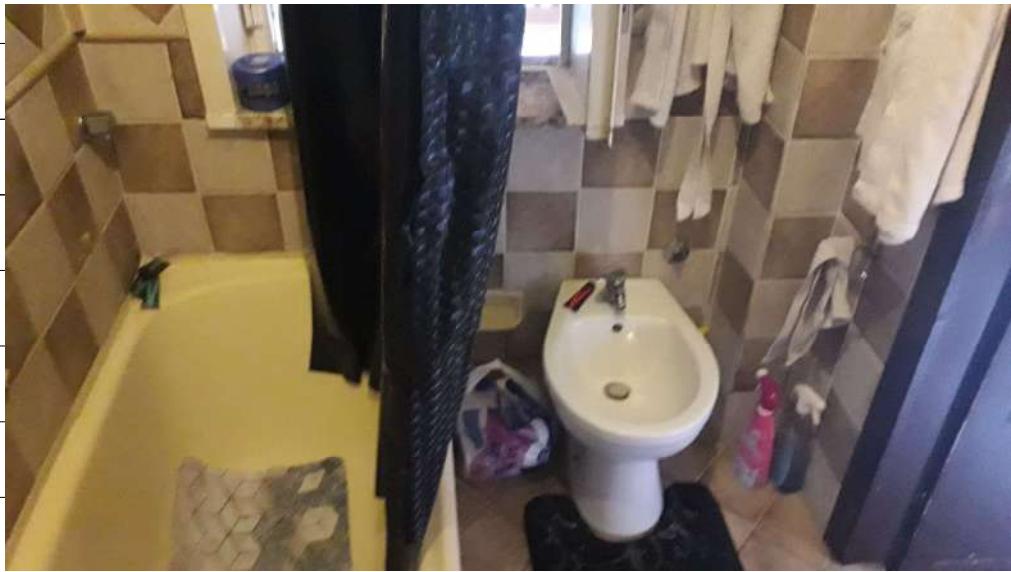
Foto n.14: immagine interna del wc ubicato al piano primo dell'immobile sito in via Sassari n.17 a Lentini.
