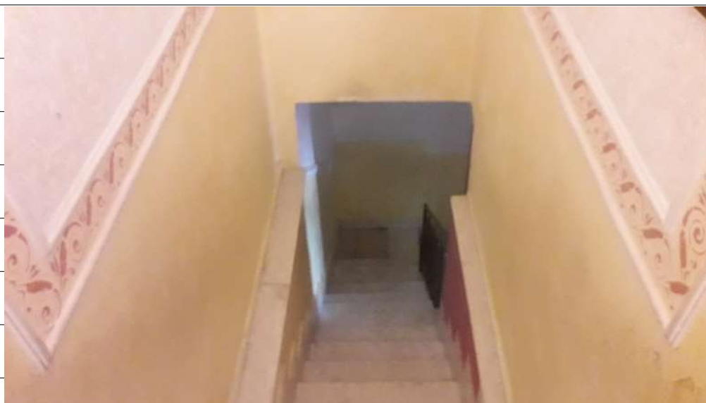
Foto n.15: immagine interna del vano scala di collegamento tra i piani primo e secondo dell'immobile sito in via Sassari n.17 a Lentini.
