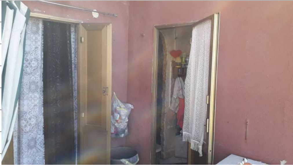
Foto n.21: immagine esterna della veranda ubicata al piano secondo dell'immobile sito in via Sassari n.17 a Lentini.
