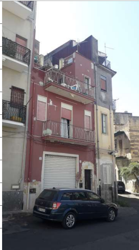
Foto n.1: immagine esterna dell'edificio sito in via Sassari nn.15 e 17 a Lentini.
