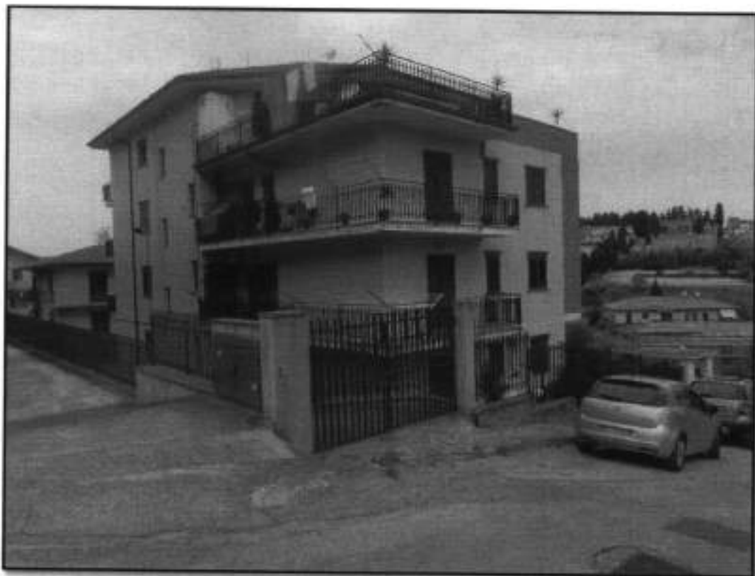
LOTTO 001 - FOTO 3 – AGIRA - Foglio 34 - Particela 380 - Sub. 2 - Vista del condominio dalla Via Moro lato Sud Ovest
