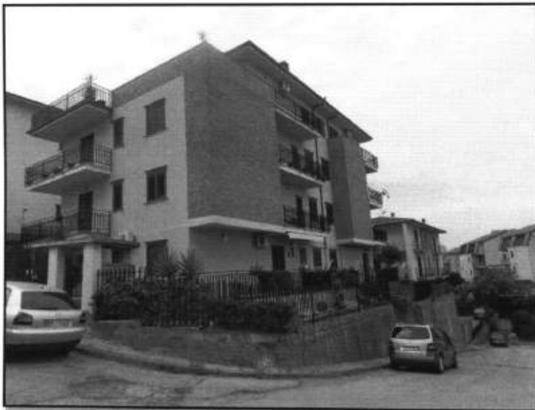
LOTTO 001 - FOTO 2 – AGIRA - Foglio 34 - Particela 380 - Sub. 2 - Vista del condominio dalla Via Moro lato Nord Est
