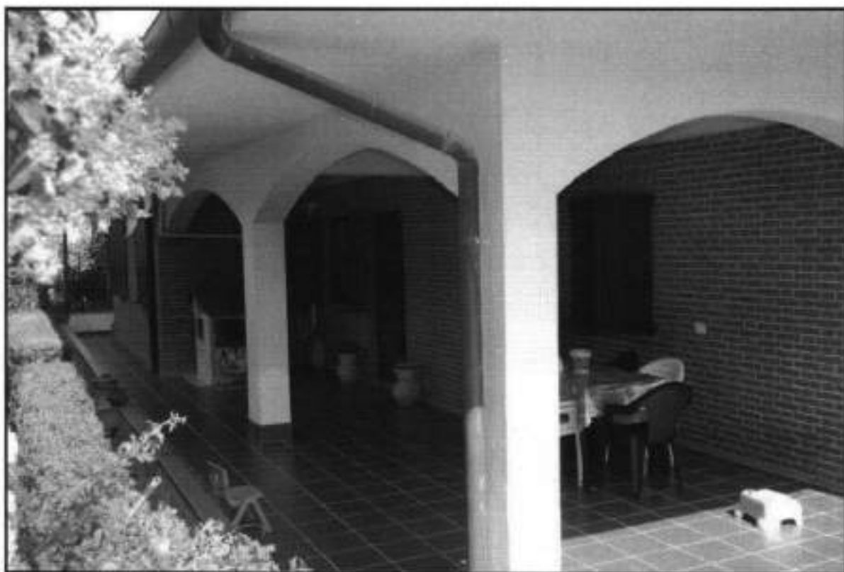
LOTTO 002/A - FOTO 3 - AGIRA - Foglio 23 - Particella 688 - Sub. 2 - Vista ingresso Piano Terra lato Sud-Est
