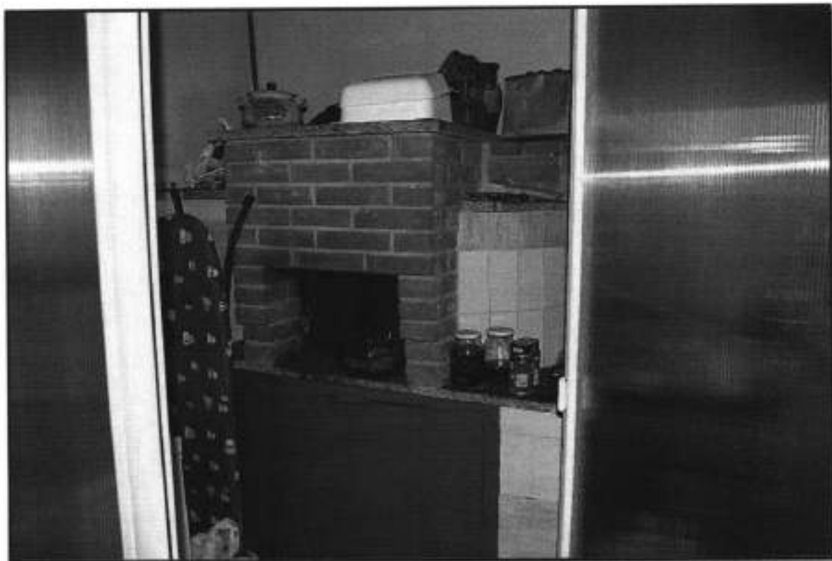
LOTTO 002/A - FOTO 38 - AGIRA - Foglio 23 - Particella 688 - Piano S1 - Ampliamento non censito - Vista del locale forno
