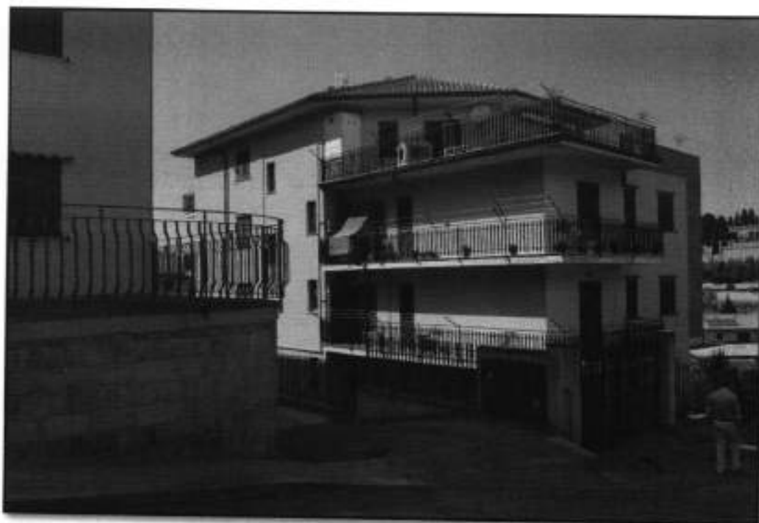
LOTTO 001 - FOTO 1 – AGIRA - Foglio 34 - Particela 380 - Sub. 2 - Vista del condominio dalla Via Moro lato Sud Ovest
