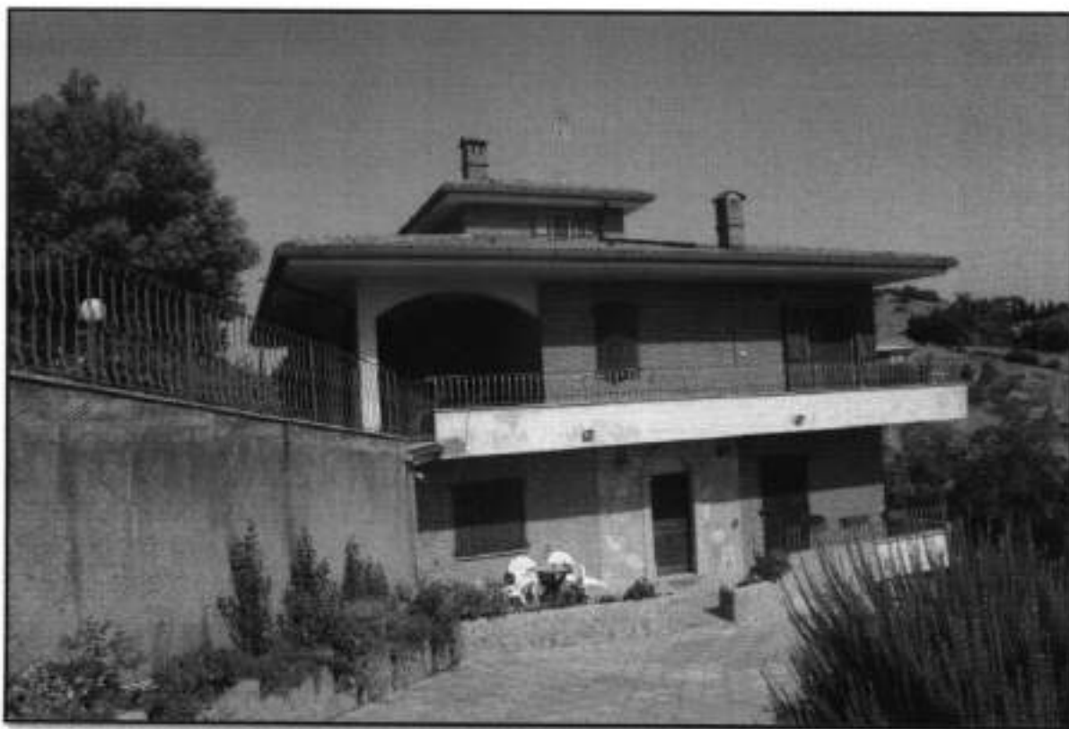
LOTTO 002/A - FOTO 1 - AGIRA - Foglio 23 - Particella 688 - Sub. 2 - Vista prospetto dalla strada di accesso al fabbricato
