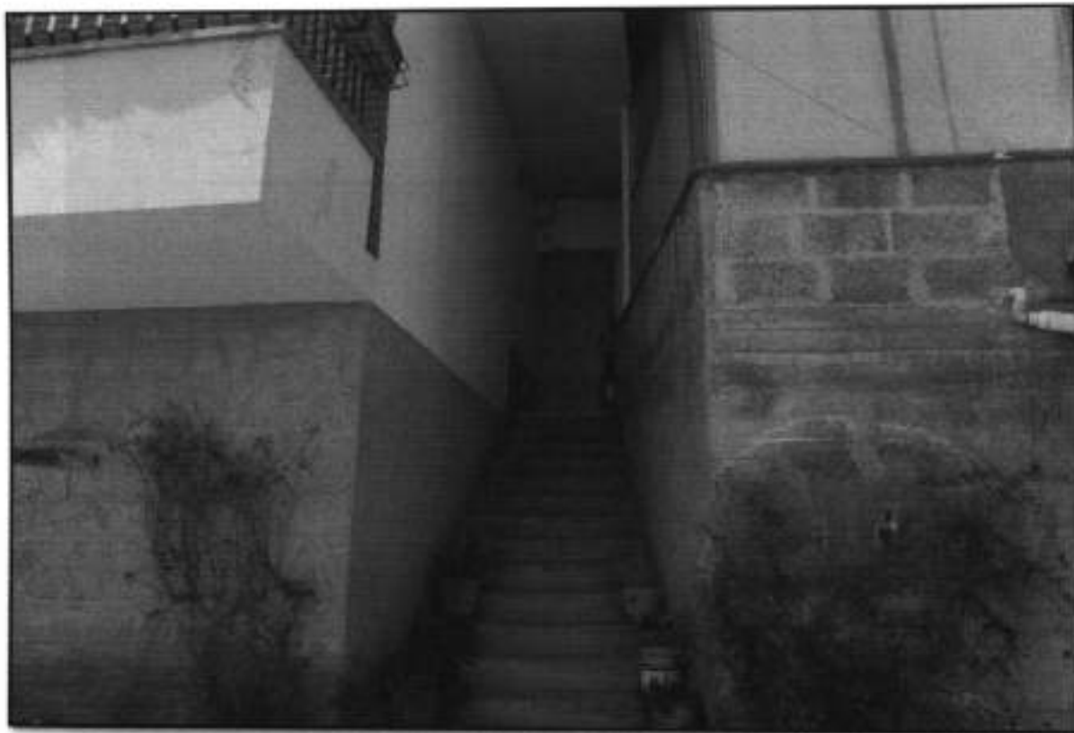
LOTTO 002/A - FOTO 39 - AGIRA - Foglio 23 - Piano S1 - Particella 688 Ampliamento non censito - Vista dell'accesso al locale ampliato
