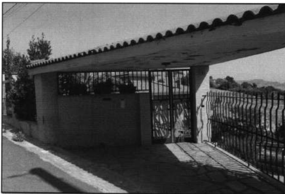
LOTTO 002/A - FOTO 5 - AGIRA - Foglio 23 - Particella 688 - Sub. 2 - Vista dell'accesso privato al Piano Terra del fabbricato
