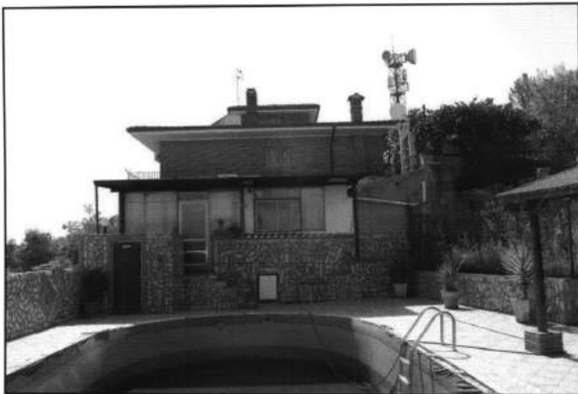
LOTTO 002/A - FOTO 4 - AGIRA - Foglio 23 - Particella 688 - Sub. 2 - Vista prospetto lato Ovest del fabbricato
