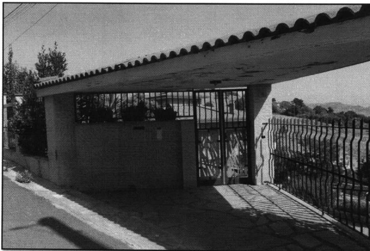
LOTTO 002/A - FOTO 5 – AGIRA - Foglio 23 - Particella 688 - Sub. 2 - Vista dell'accesso privato al Piano Terra del fabbricato
