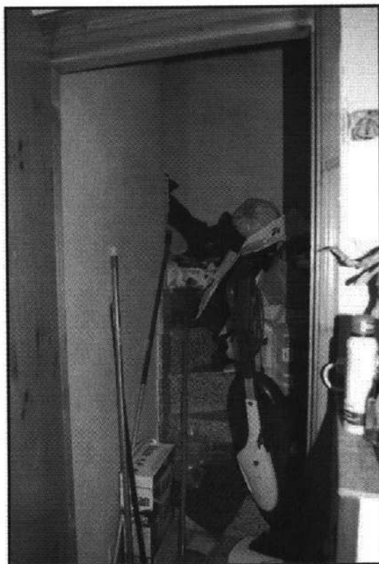
LOTTO 002/A - FOTO 15 – AGIRA - Foglio 23 - Particella 688 - Sub. 2 – Piano S1 Vista ripostiglio al piano S.1 ricavato nella scala interna chiusa che conduceva al piano terra
