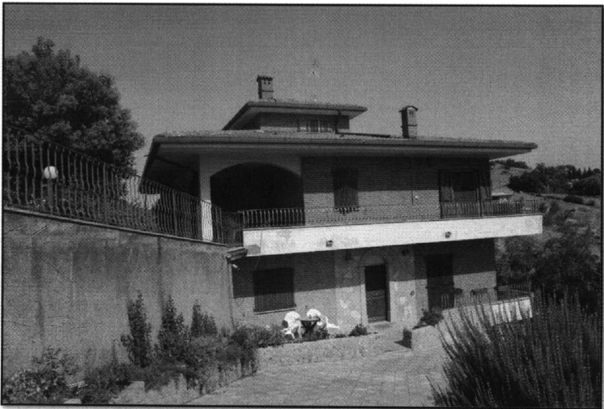
LOTTO 002/A - FOTO 1 – AGIRA - Foglio 23 - Particella 688 - Sub. 2 - Vista prospetto dalla strada di accesso al fabbricato
