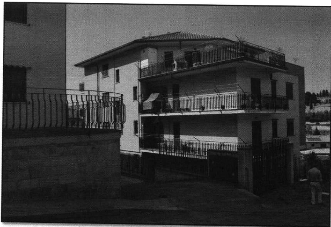
LOTTO 001 - FOTO 1 – AGIRA - Foglio 34 - Particela 380 - Sub. 2 - Vista del condominio dalla Via Moro lato Sud Ovest
