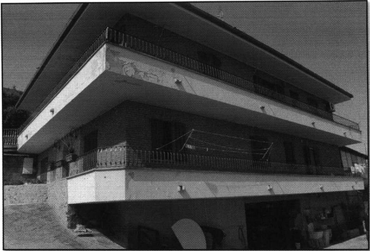
LOTTO 002/A - FOTO 2 – AGIRA - Foglio 23 - Particella 688 - Sub. 2 - Vista prospetto Nord del fabbricato
