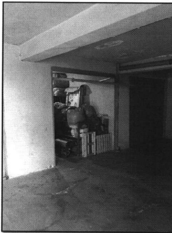
LOTTO 001- Corpo B - FOTO 17 – AGIRA - Foglio 34 - Particela 380 - Sub. 13 - Vista ingresso box
