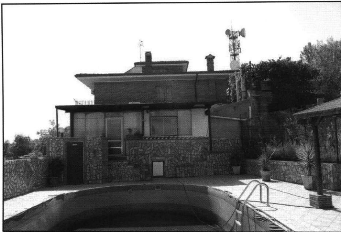
LOTTO 002/A - FOTO 4 – AGIRA - Foglio 23 - Particella 688 - Sub. 2 - Vista prospetto lato Ovest del fabbricato
