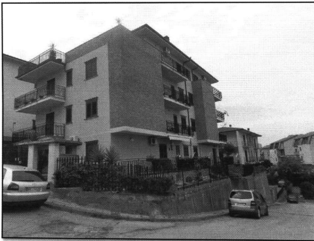
LOTTO 001 - FOTO 2 – AGIRA - Foglio 34 - Particela 380 - Sub. 2 - Vista del condominio dalla Via Moro lato Nord Est
