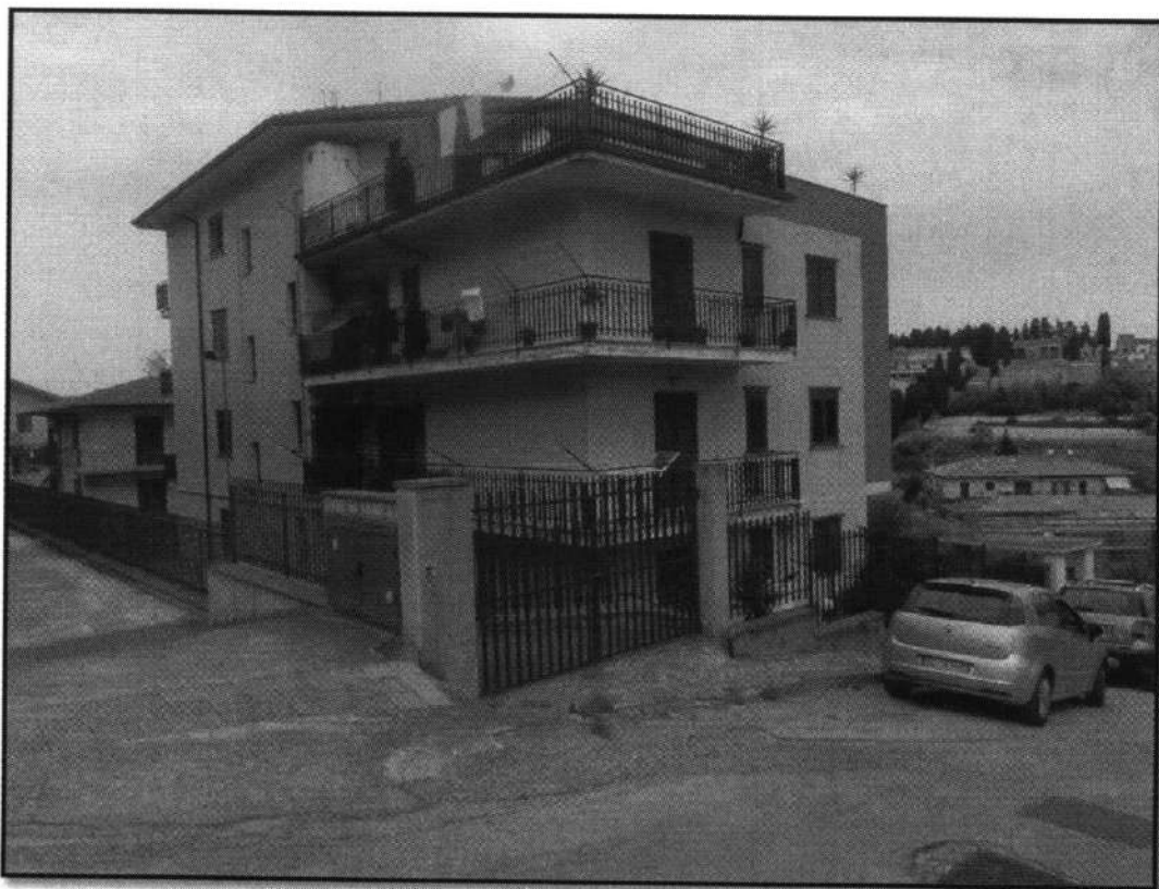
LOTTO 001 - FOTO 3 – AGIRA - Foglio 34 - Particela 380 - Sub. 2 - Vista del condominio dalla Via Moro lato Sud Ovest
