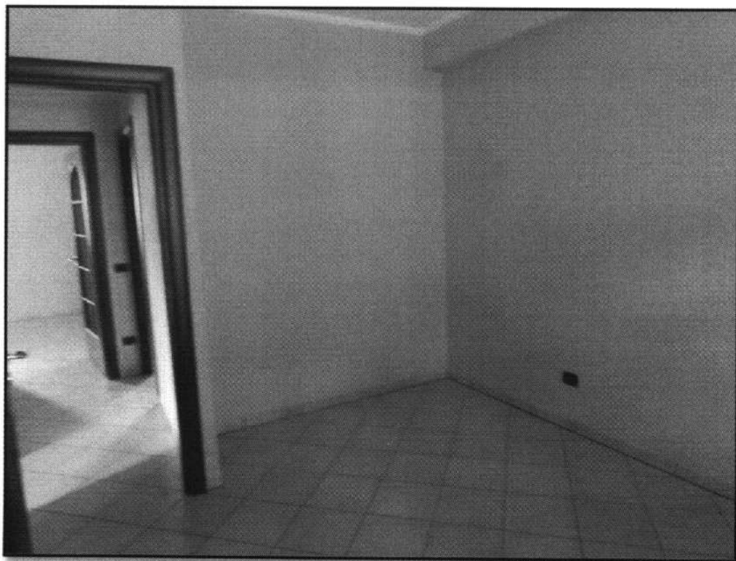
LOTTO 001- Corpo A - FOTO 13 – AGIRA - Foglio 34 - Particela 380 - Sub. 2 - Vista Letto 2
