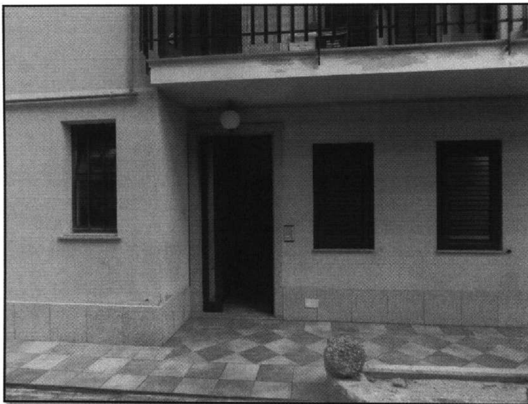
LOTTO 001 - FOTO 4 – AGIRA - Foglio 34 - Particela 380 - Sub. 2 - Ingresso condominiale dalla Via Moro
