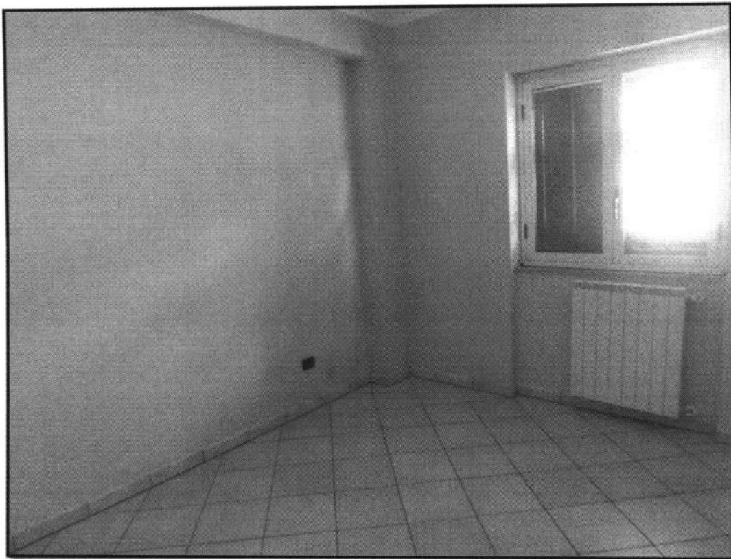
LOTTO 001- Corpo A - FOTO 12 – AGIRA - Foglio 34 - Particela 380 - Sub. 2 - Vista Letto 2
