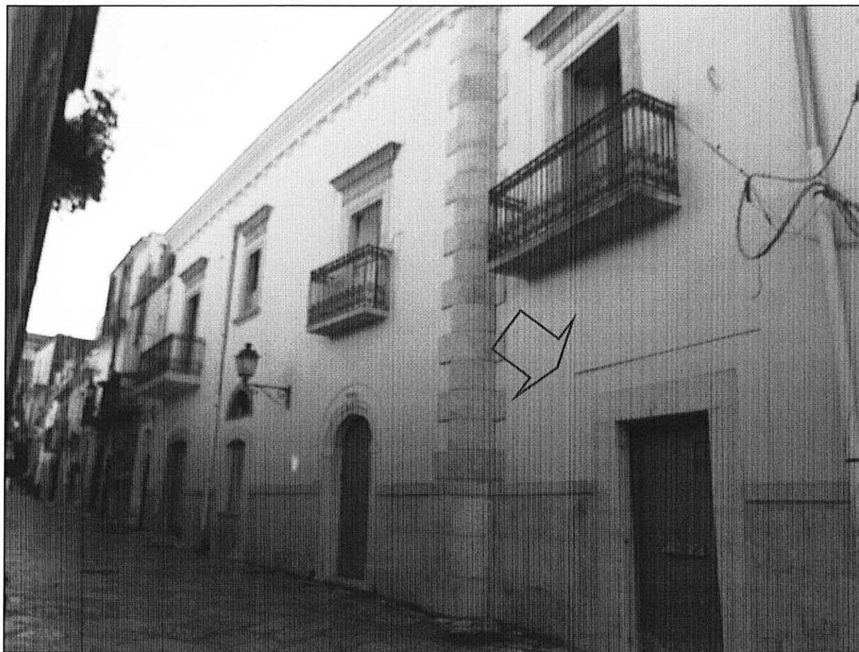
Figura 23. Accesso al civico 40 di Via Nazario Sauro che immette nell'unità immobiliare censita al foglio 39, p.la 484, sub. 12 del comune di Apricena.
