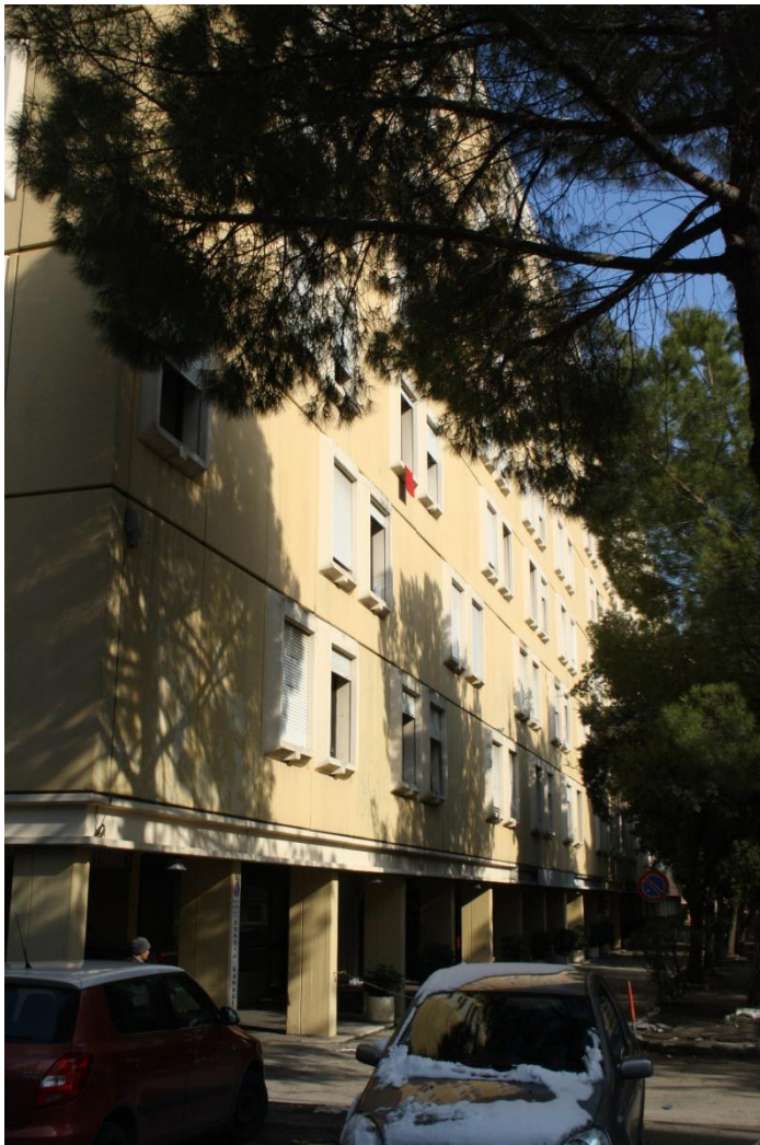
Fabbricato di Via della Pescara
