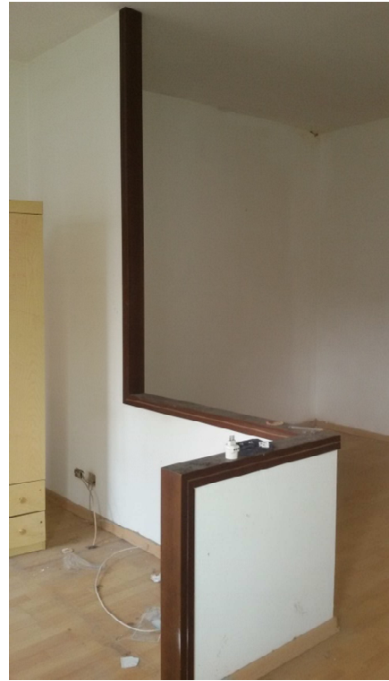
Setto e muretto di separazione dal soggiorno-pranzo
