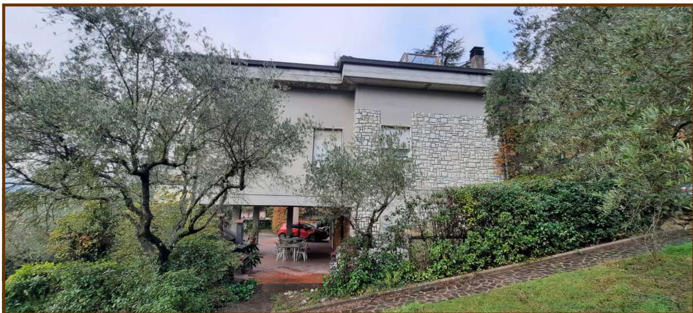
VISTA PROSPETTO OVEST
