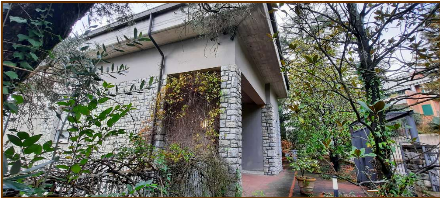
VISTA LATERALE INGRESSO PEDONALE
