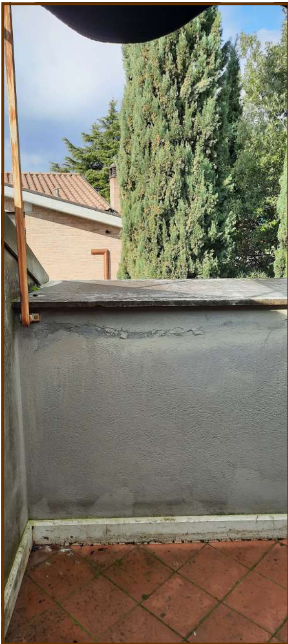
TERRAZZO - APPARTAMENTO P.PRIMO
