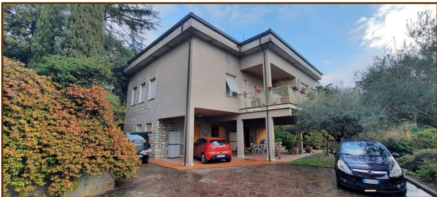
VISTA PROSPETTO SUD—EST
