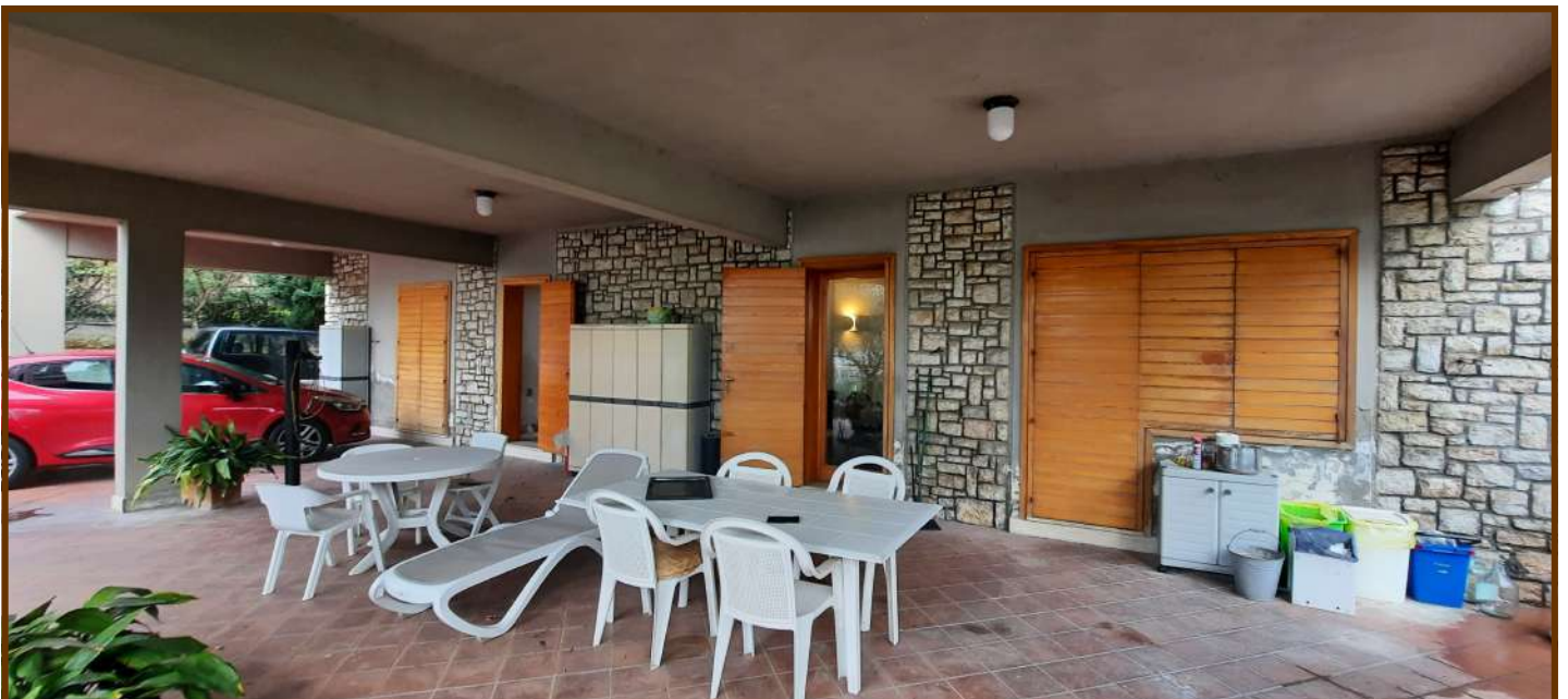
PORTICATO AL PIANO SOTTOSTRADA
