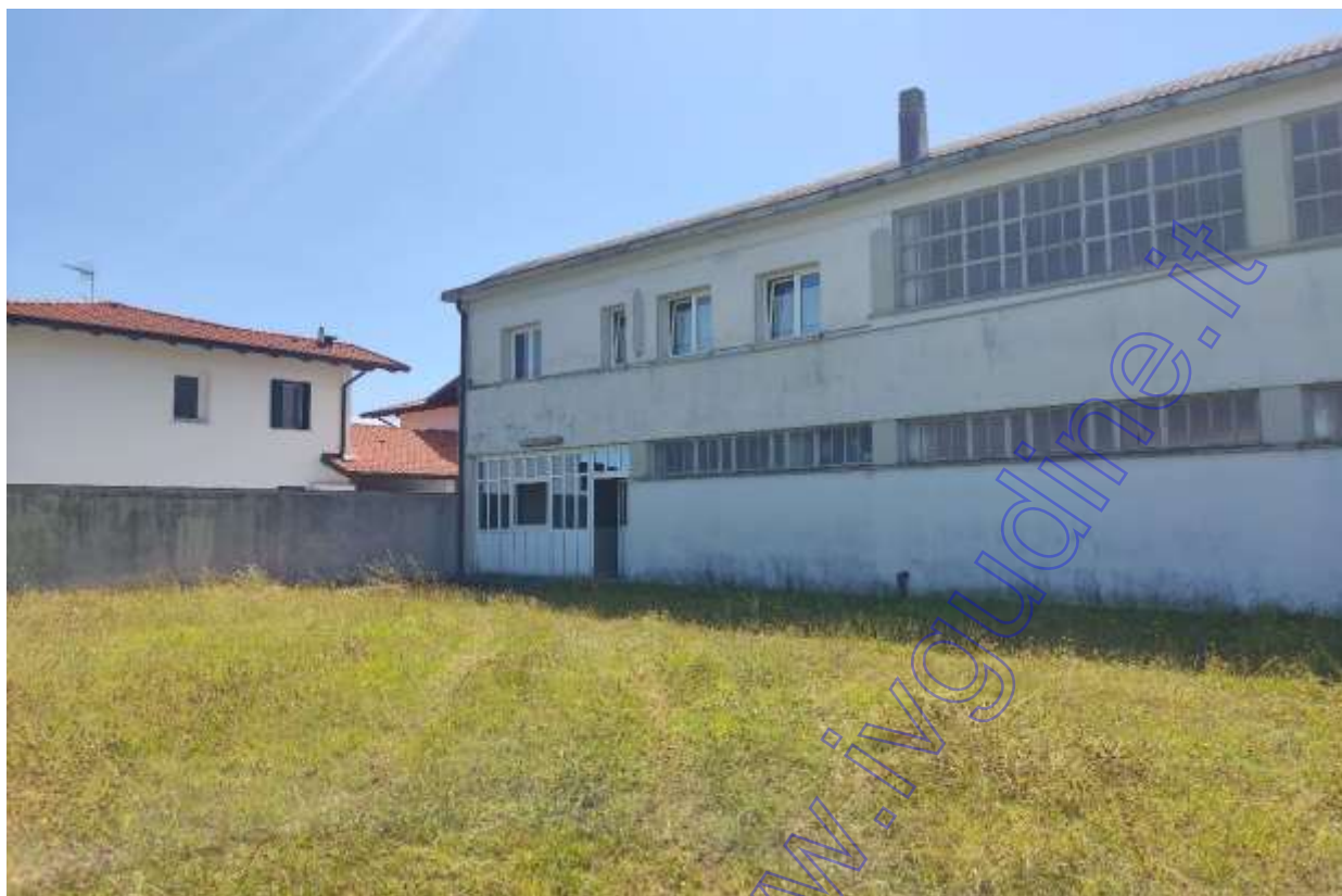
Lato Nord Particolare
