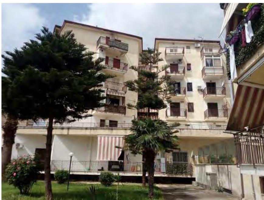
FOTO N. 21 – Altra vista del fabbricato A
