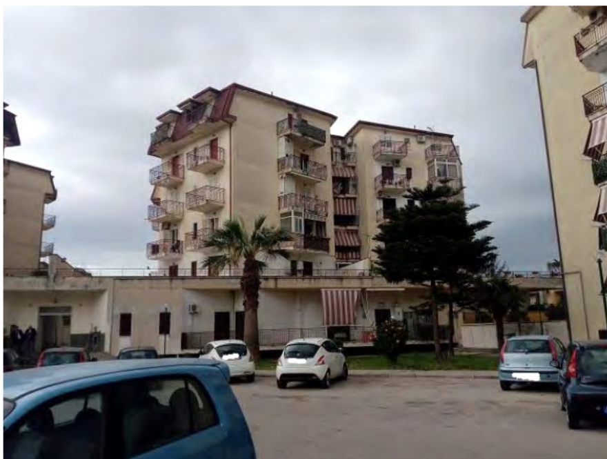
FOTO N. 22 – Altra vista del fabbricato A
