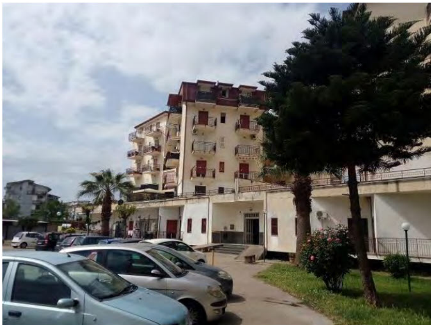
FOTO N. 20 – Vista d'insieme del fabbricato A di cui fa parte l'appartamento pignorato
