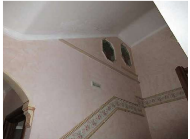
FOTO N.15 – VANO SCALA TRA PRIMO E SECONDO PIANO
