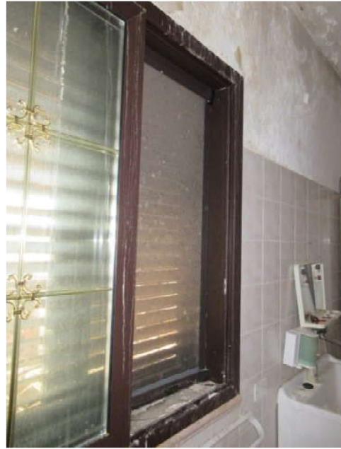
FOTO N.27 – VANO LAVANDERIA PIANO TERZO
