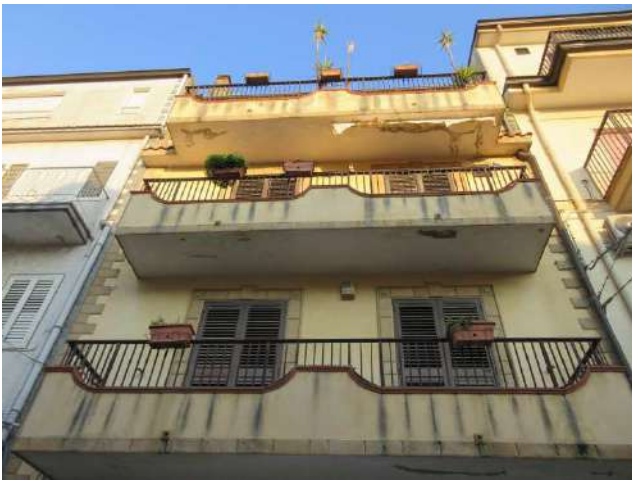
FOTO N.4 - PROSPETTO VIA COSENTINO
