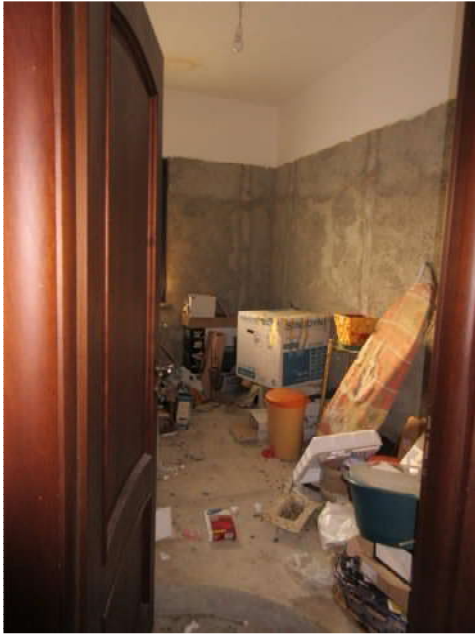
FOTO N.22 – VANO BAGNO PIANO SECONDO
