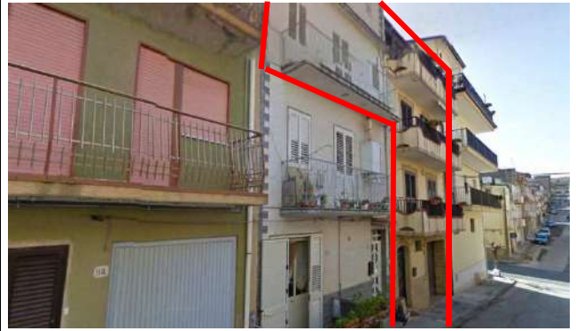
FOTO N.3- PROSPETTO VIA COSENTINO
