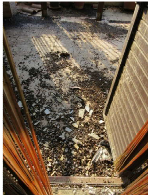
FOTO N.29 –TERRAZZA PIANO TERZO
