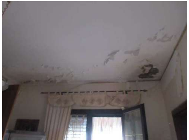
FOTO N.25 – VANO CUCINA PIANO TERZO
