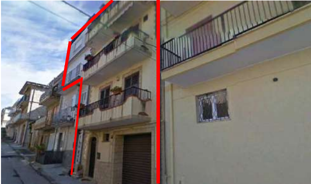
FOTO N.2 - PROSPETTO VIA COSENTINO
