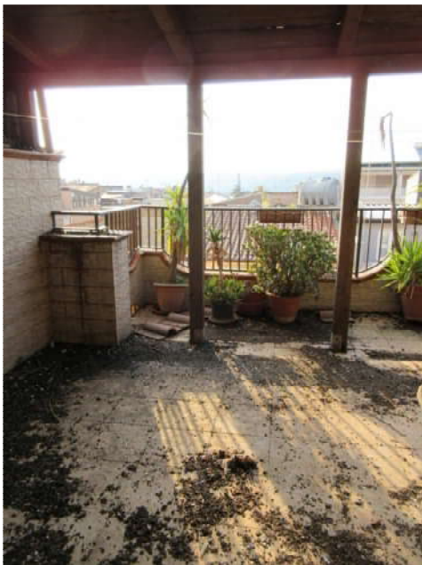
FOTO N.28 –TERRAZZA PIANO TERZO
