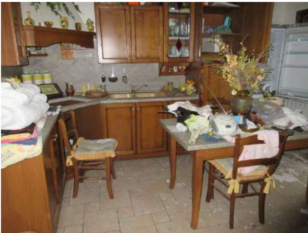
FOTO N.24 – VANO CUCINA PIANO TERZO
