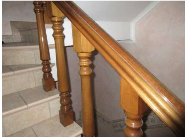
FOTO N.23 - VANO SCALA TRA SECONDO E TERZO PIANO
