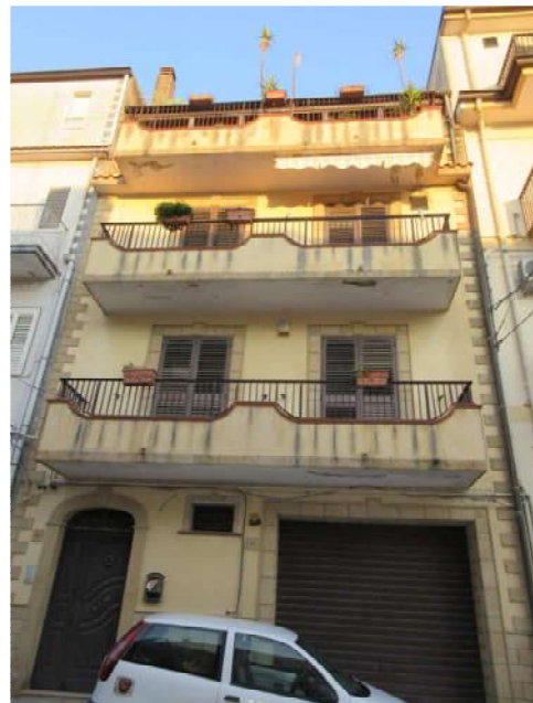
FOTO N.5 – PROSPETTO VIA COSENTINO
