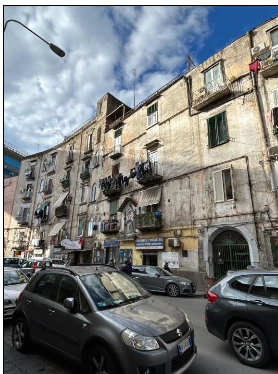
Prospetto del fabbricato sulla strada
