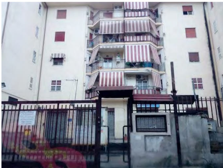
FOTO N. 40 – Ingresso principale del Parco Bonifico
