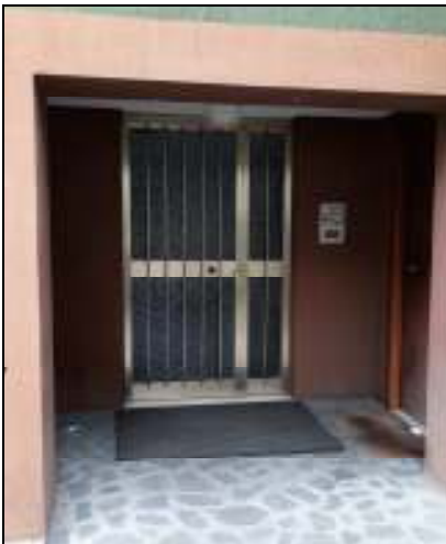
Ingresso al vano scala
