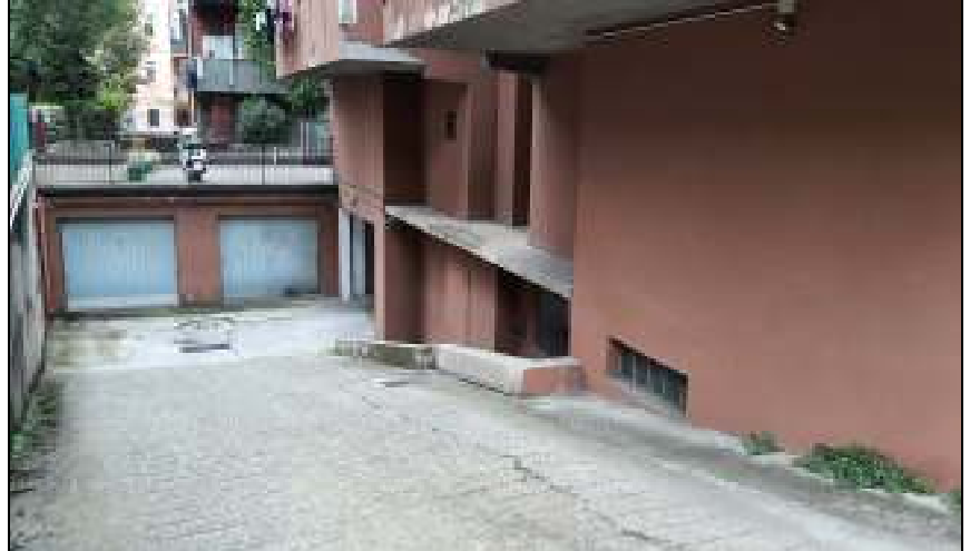
Ingresso al piano interrato
