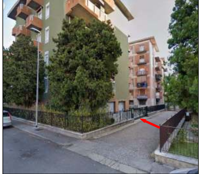
Ingresso da via Toniolo sul retro dell'edificio
