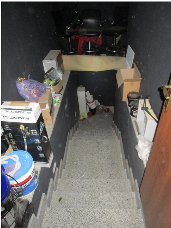
Foto 11/12 – Scala interna (scala 1) di collegamento tra piano terra e interrato
