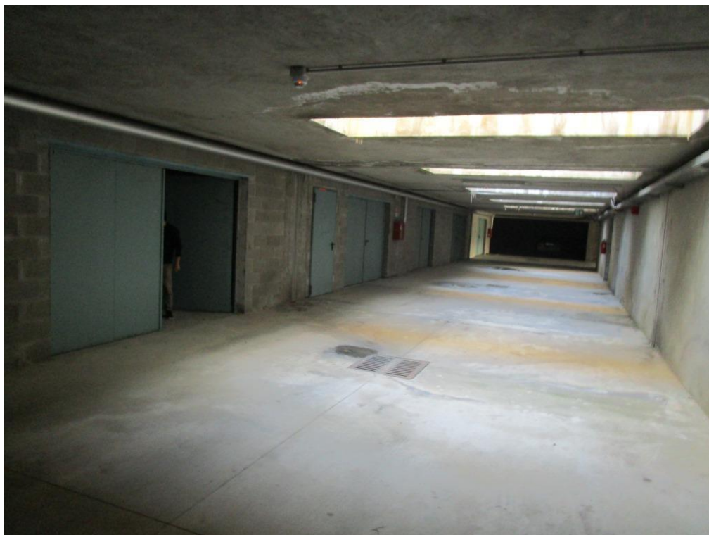
Foto 22 – Vista, dal corsello box al piano interrato, degli ingressi al magazzino
