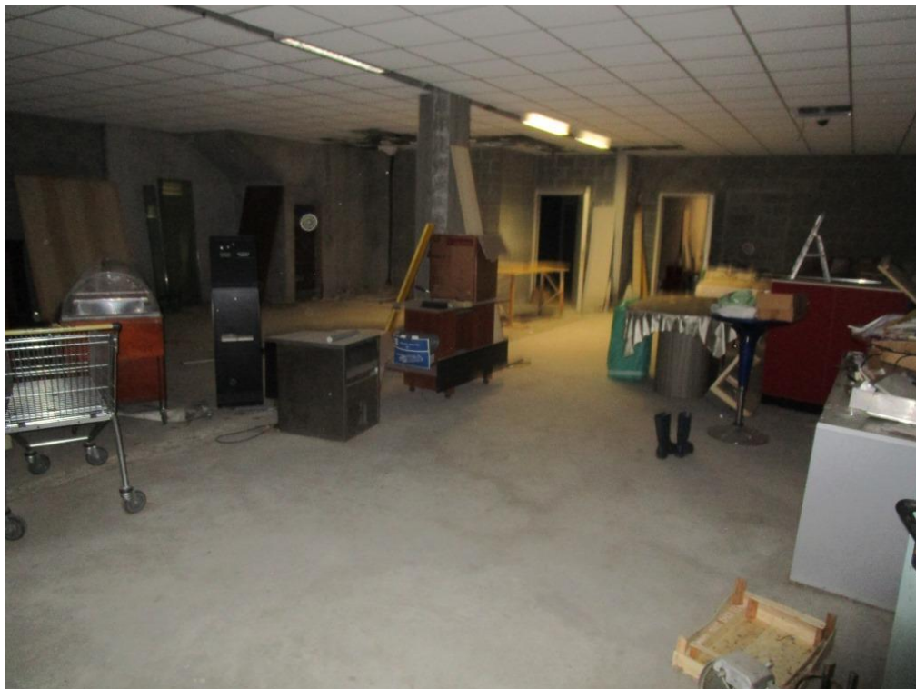
Foto 20 – Magazzino al piano interrato
