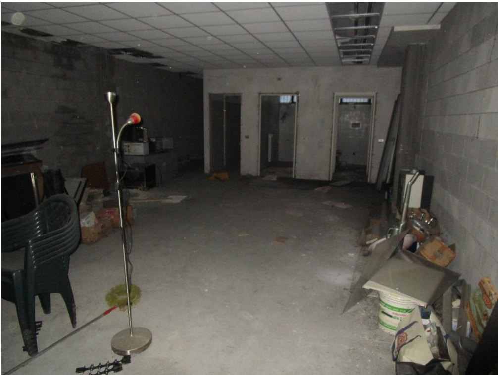
Foto 17 – Servizi igienici al piano interrato
