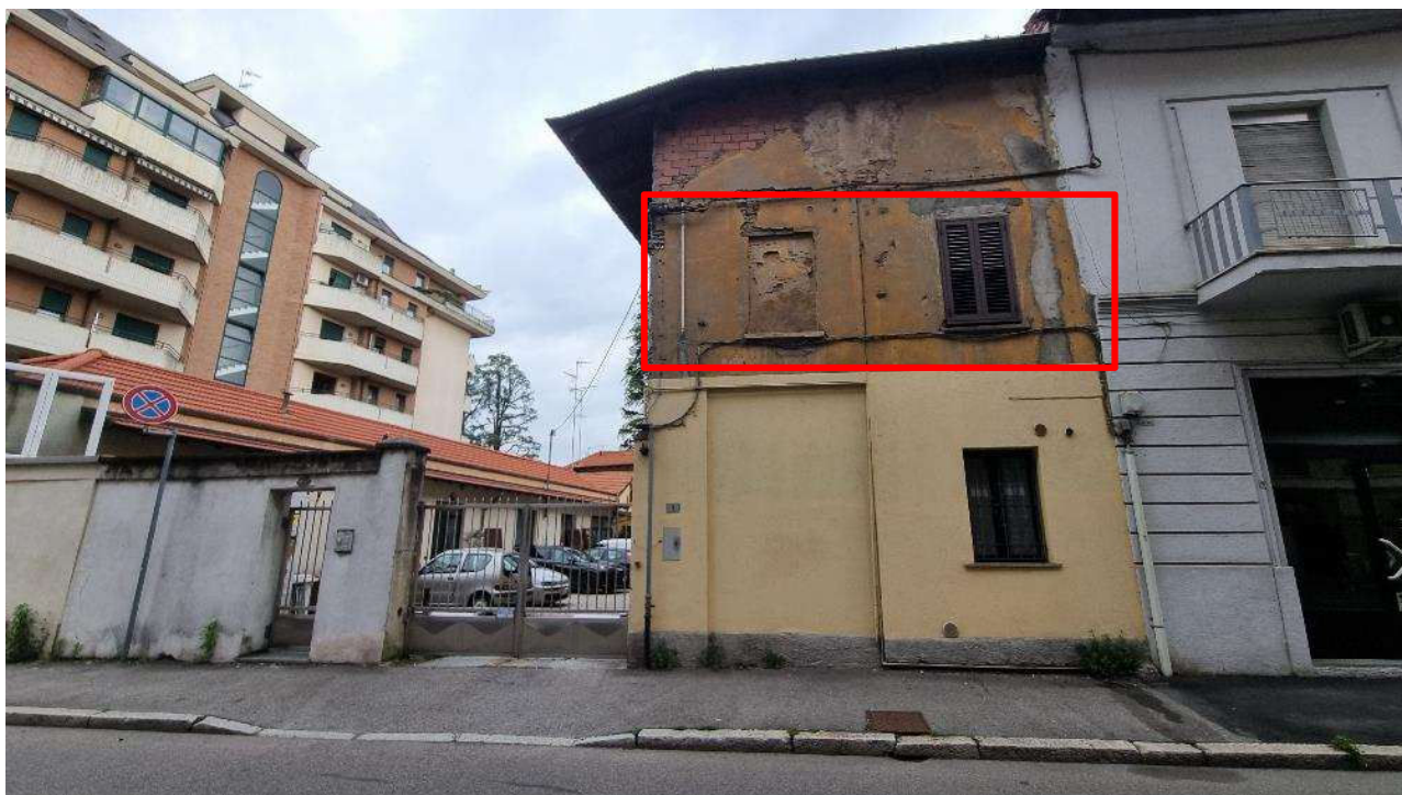
FACCIATA SU VIA GAVINANA
