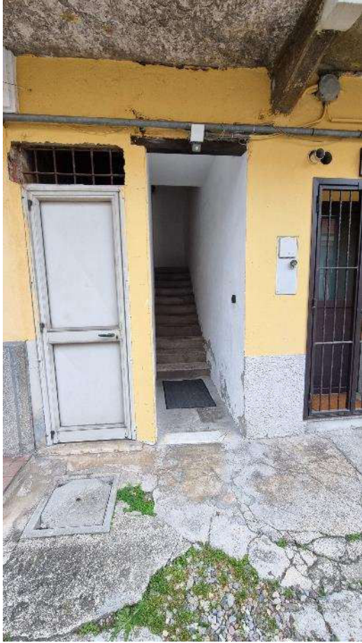
INGRESSO ALLA SCALA COMUNE
