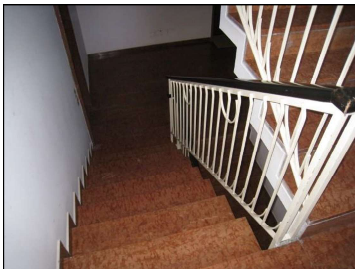
FOTO 9 VISTA DEL VANO SCALA CONDOMINIALE.
