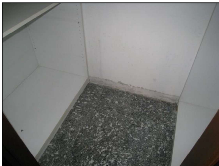
FOTO 12 U.I. MAPPALE 17429 SUB. 20 VISTA INTERNA DELL'U.I. OGGETTO DI PROCEDURA ESECUTIVA. LA FOTO RIPRENDE IL RIPOSTIGLIO.
