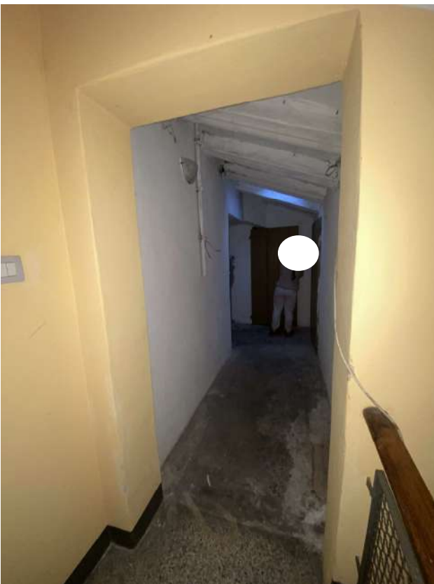
FOTO 16: Accesso locale nel sottotetto
