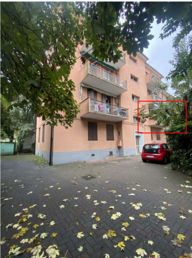
FOTO 4: Vista esterna fabbricato
