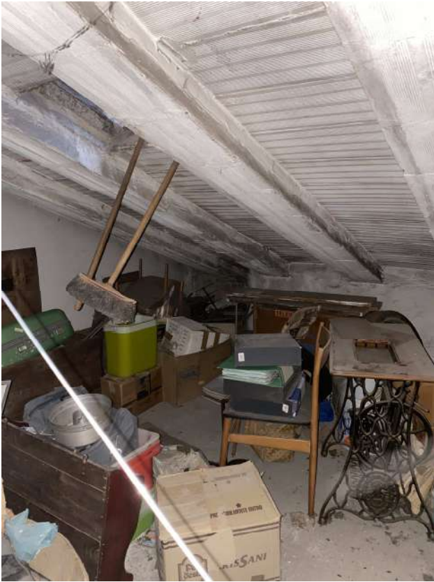
FOTO 17: Locale magazzino nel sottotetto
