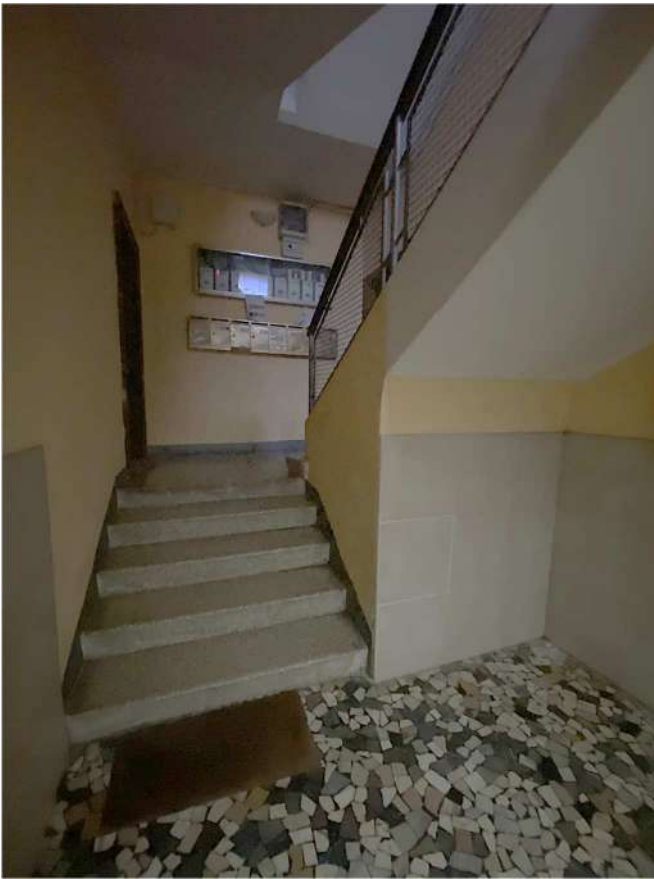
FOTO 5: Vista ingresso/vano scala condominiale
