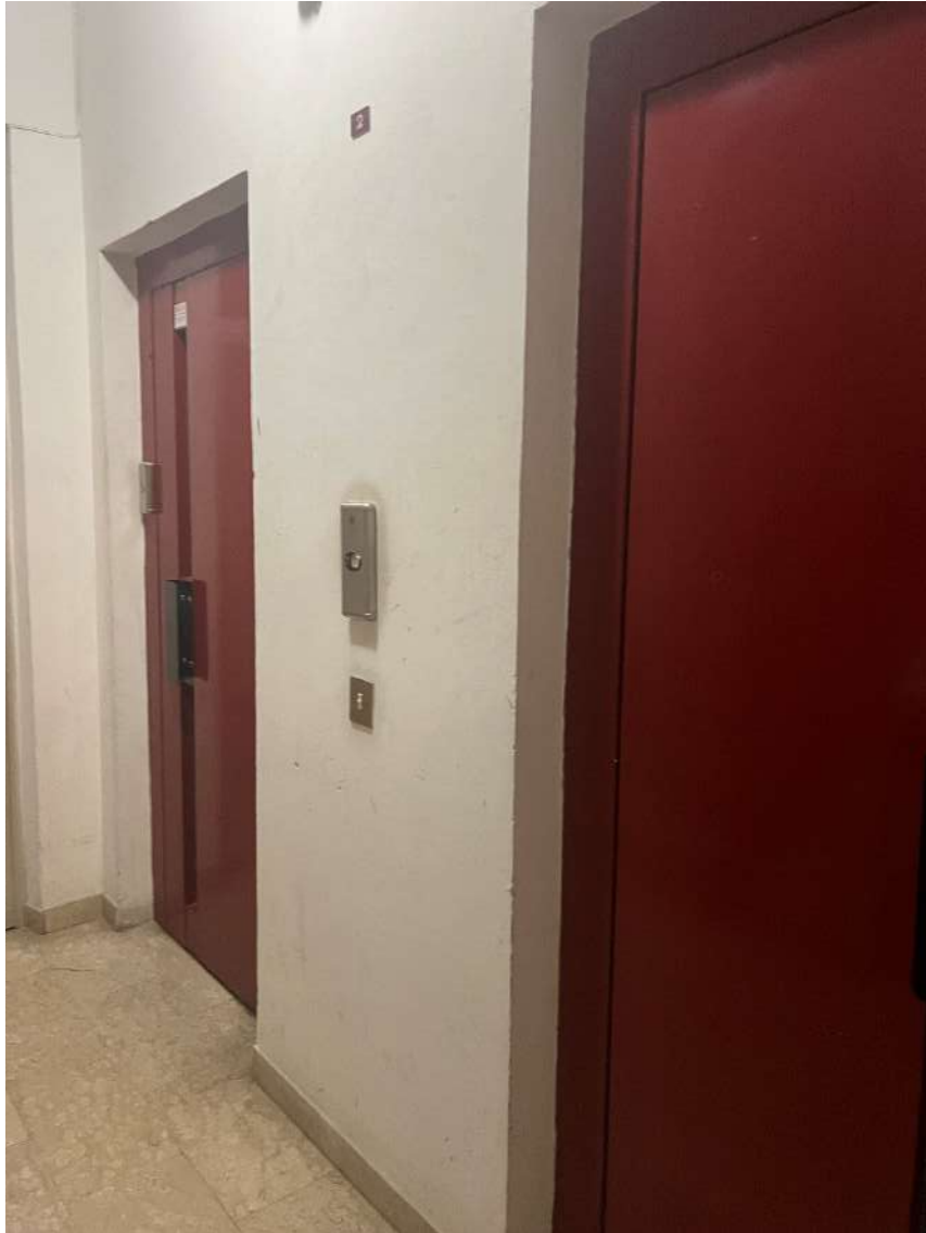
FOTO 5 – Vano Ascensore arrivo piano terzo
