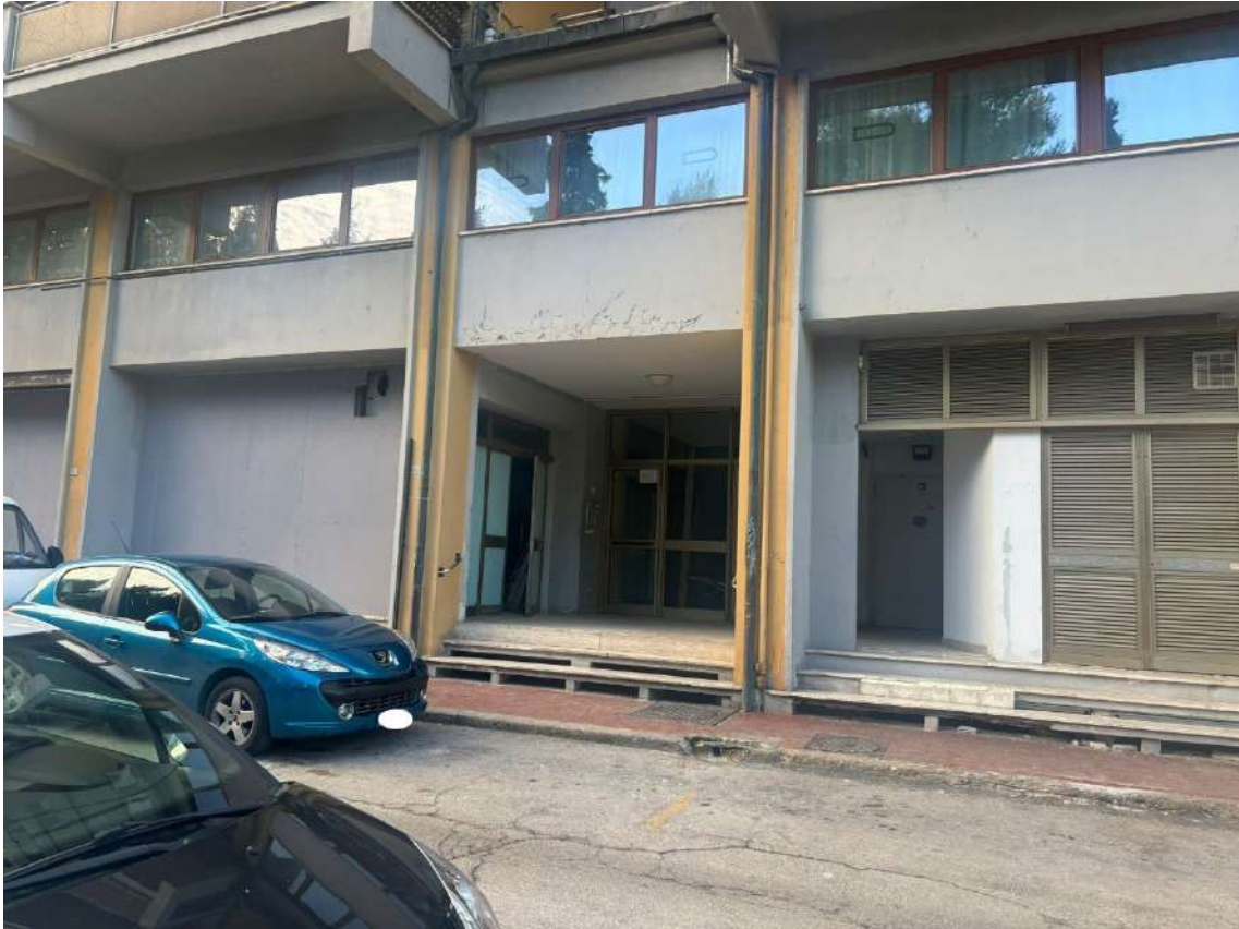
FOTO 1 – Vista ingresso del fabbricato
