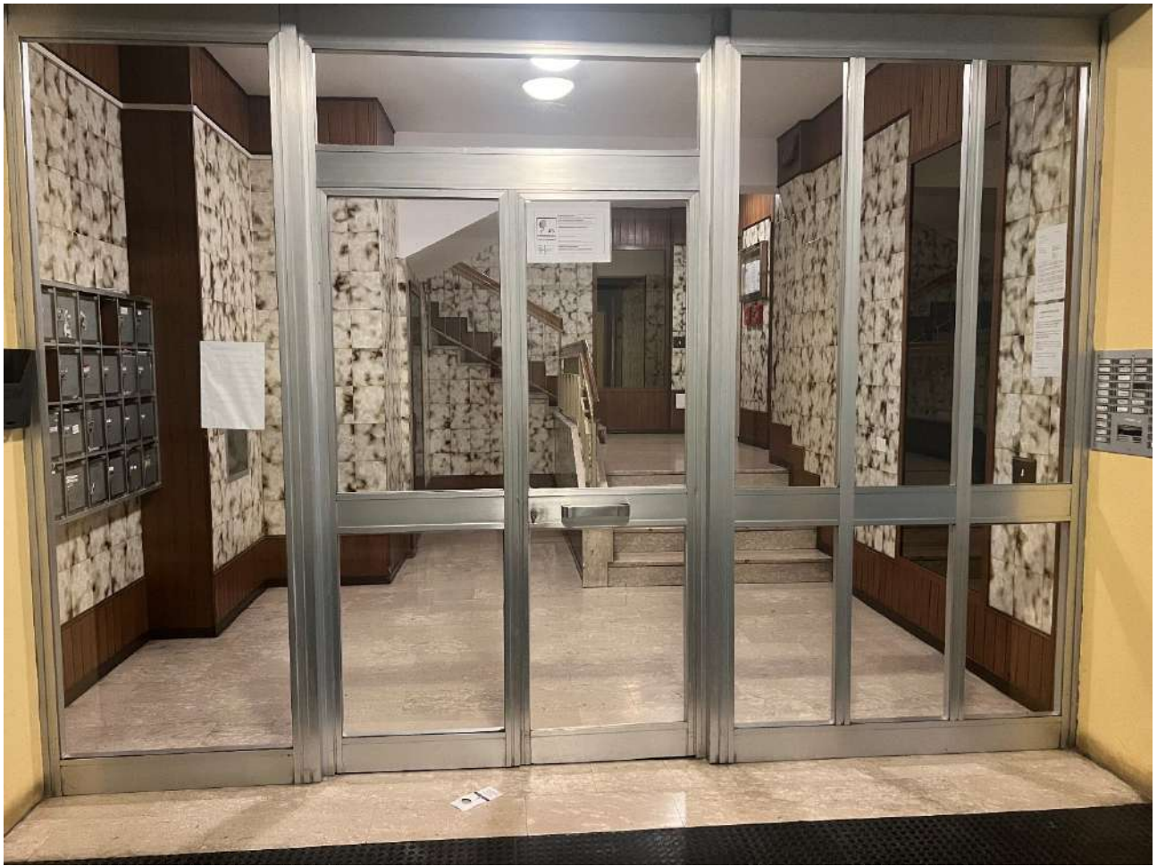
FOTO 4 – Vista ingresso scala B del fabbricato
