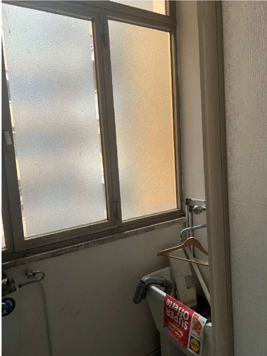
Foto 16 – Balcone chiuso adibito a wc
