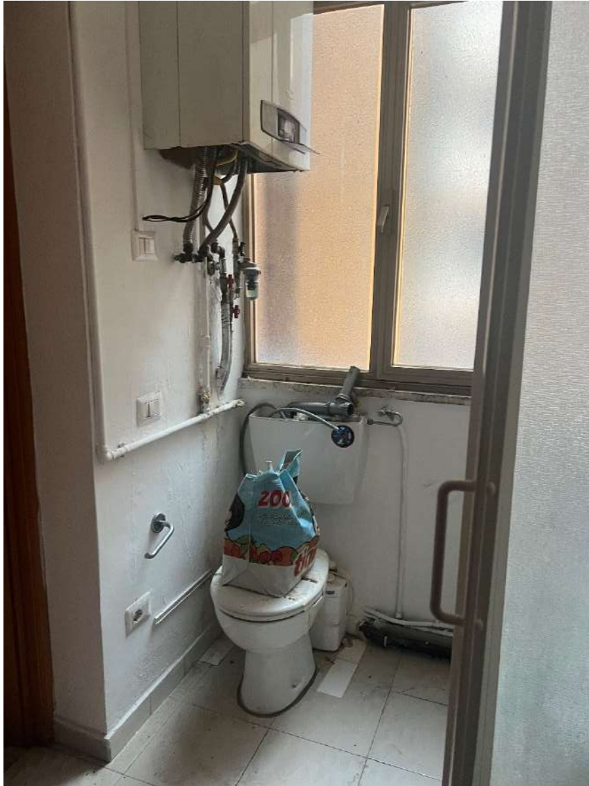
Foto 18 – Balcone chiuso adibito a wc
