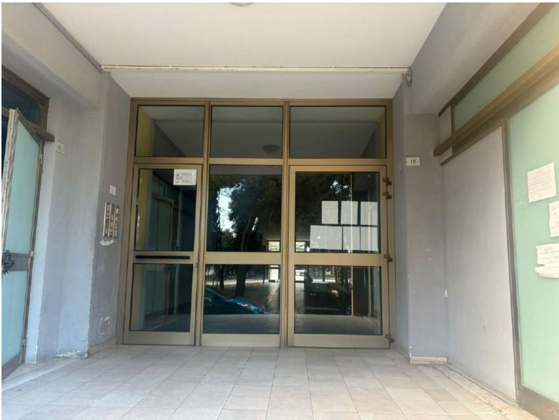
FOTO 2 – Vista ingresso del fabbricato
