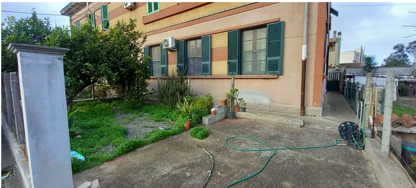
Immagine 1: Vista Prospetto principale dalla via Roma
