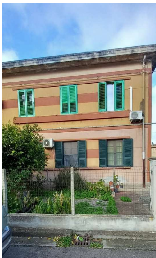
Immagine 2: Vista Prospetto principale dalla via Roma
