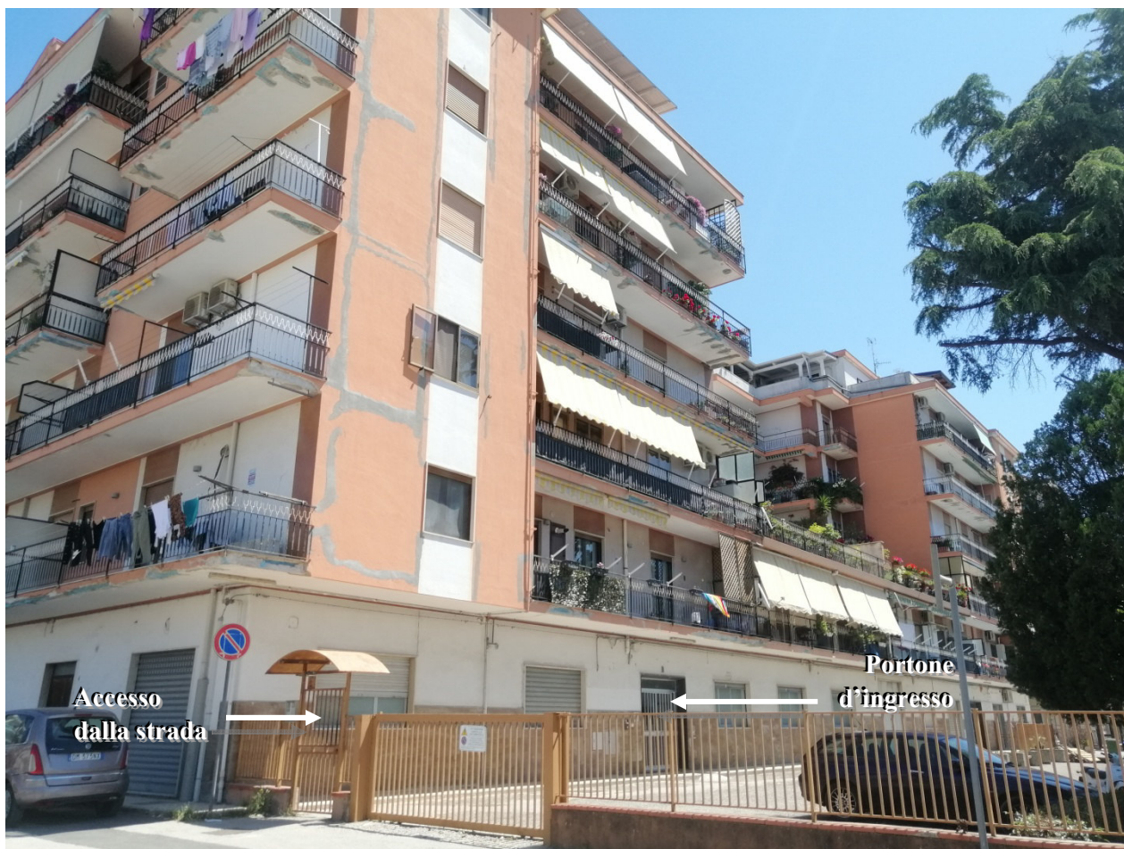
Foto esterna del Fabbricato
