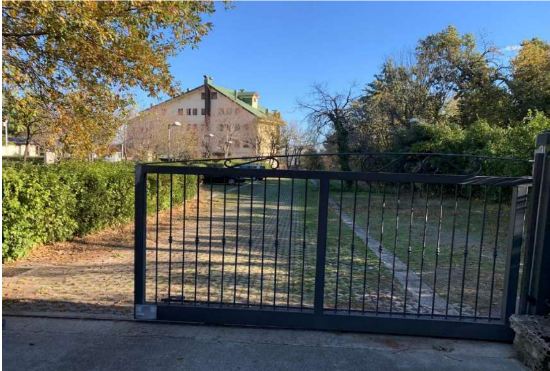
[4] Vista da Sud del complesso immobiliare
