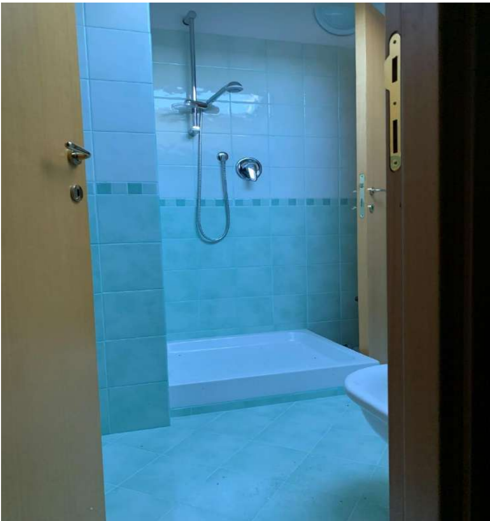
FOTO 18 - Bagno Piano sottotetto
