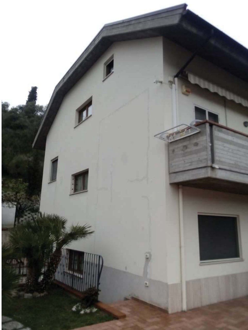
FOTO N.1: VISTA DEL PROSPETTO SUD
