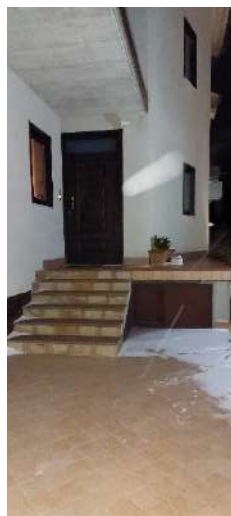
Foto 03 – Vista ingresso lato sud-est
