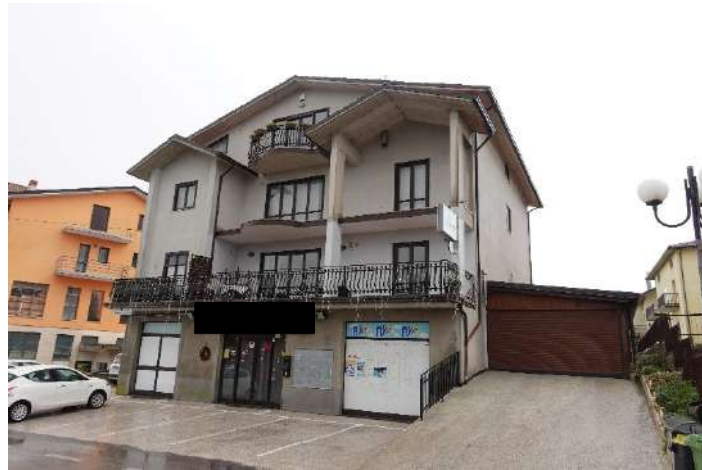
Foto 01 – Vista lato nord-ovest
