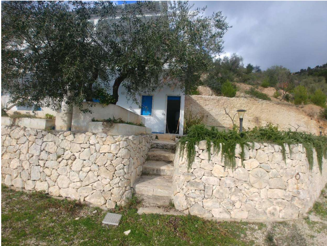
Figura 57: pianerottolo di acceso al ballatoio
