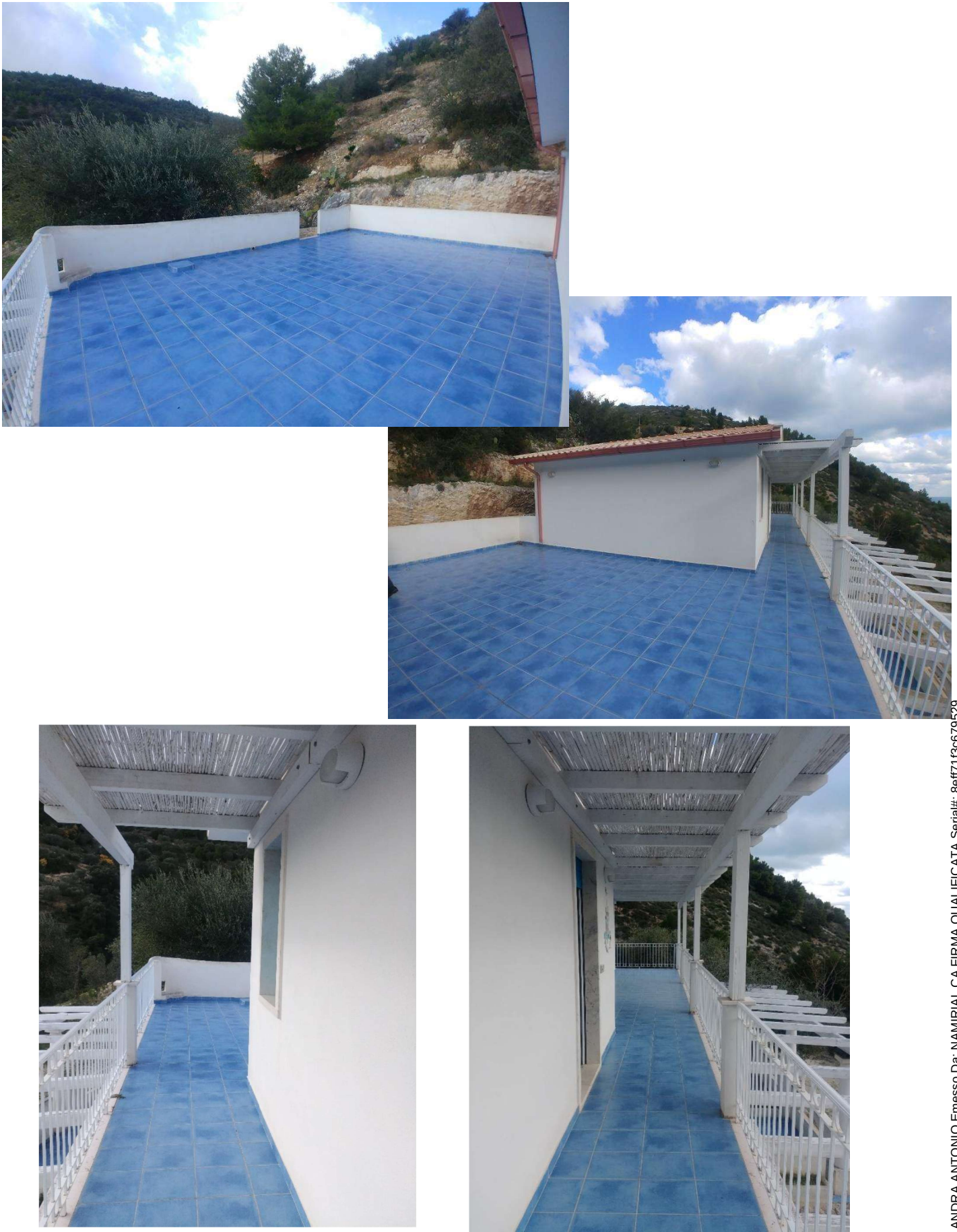
Figura 18: terrazzo al piano primo e ballatoio di accesso alle unità immobiliari
