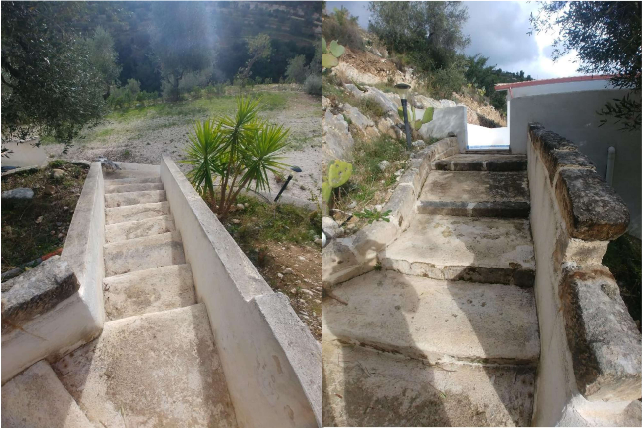
Figura 17: scala di accesso al piano primo
