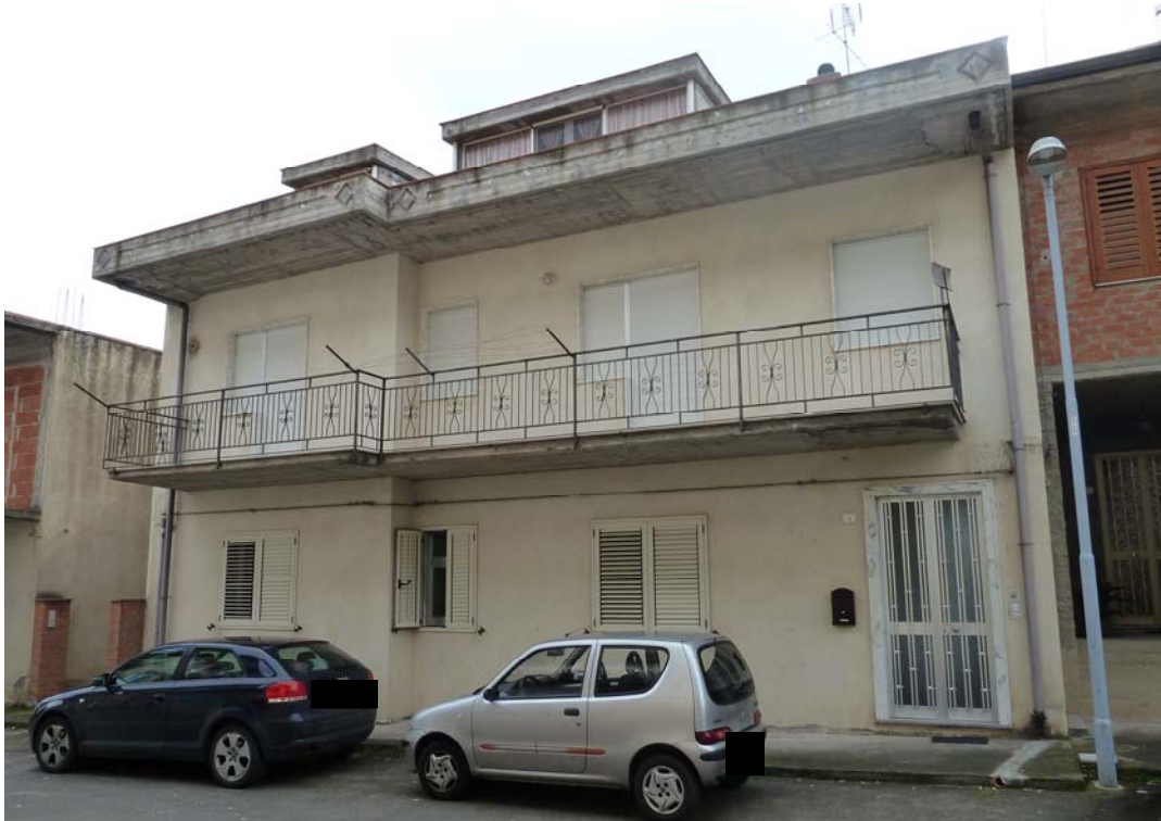
FOTO 1: PROSPETTO FABBRICATO DALLA VIA TIBULLO N. 4
