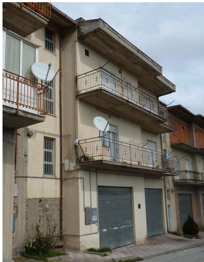
FOTO 2: PROSPETTO FABBRICATO DALLA VIA TRAIANO N. 9
