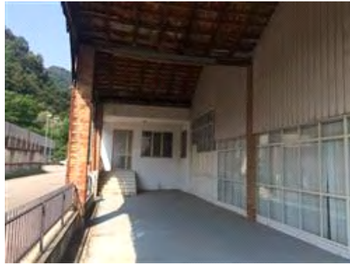
Vista esterna - Portico di ingresso zona uffici
