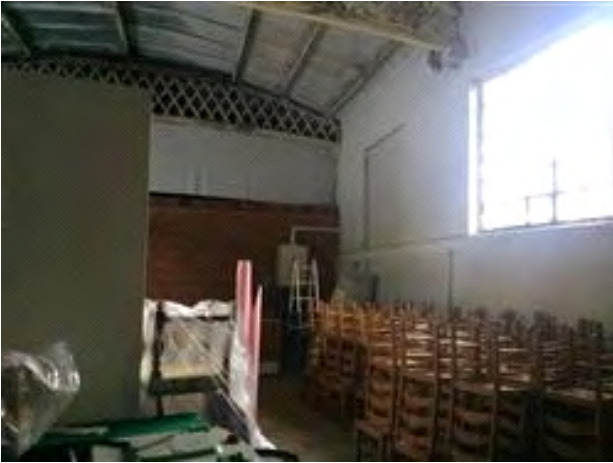
Vista interna - magazzino/deposito
