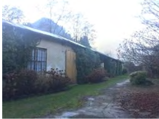
Vista esterna - zona nord
