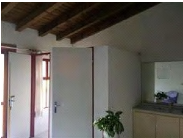
Vista interna - parte utilizzata
