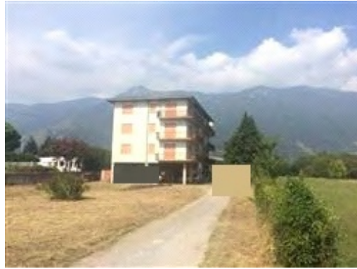
Vista Esterna intero edificio
