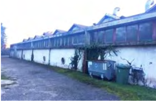
Vista esterna - Lato ampliamento
