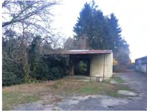
Vista esterna - Centrale Termica - Tettoia
