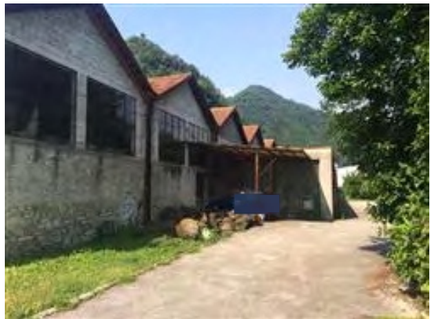
Vista esterna - lato ampliamento
