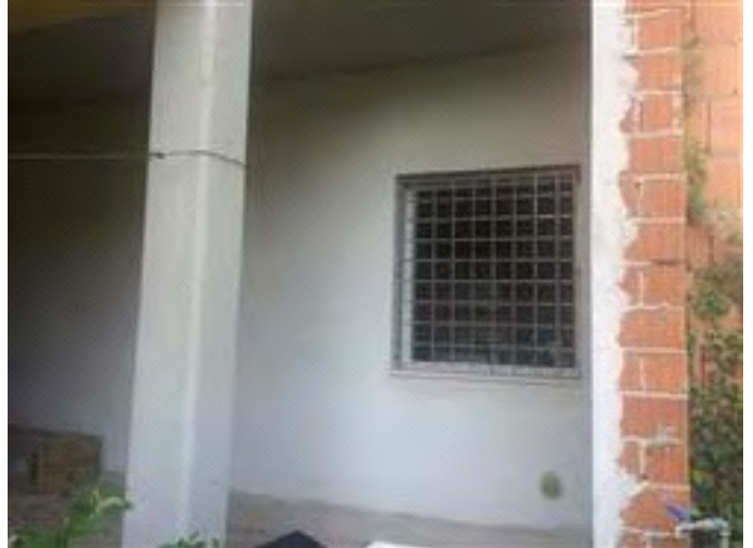
Vista deposito esterno
