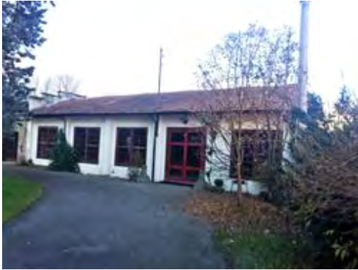
Vista esterna - ingresso
