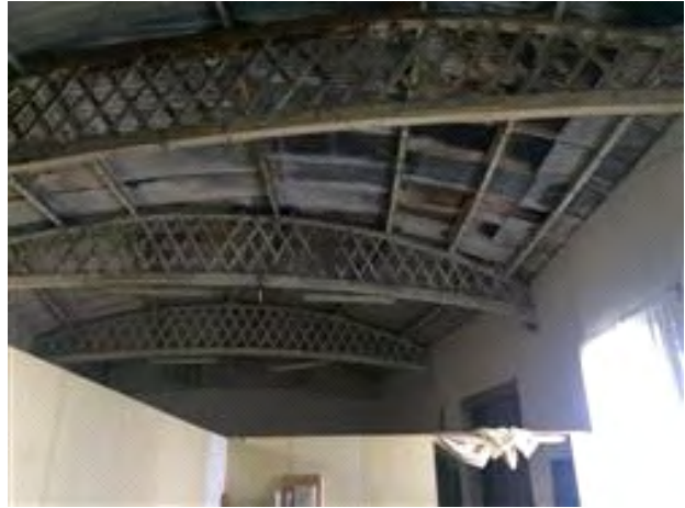
Vista interna - magazzino/deposito
