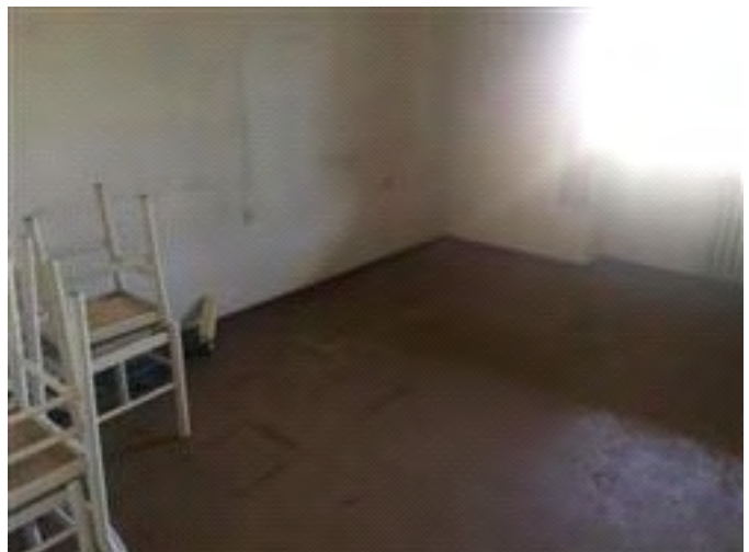
Vista interna - lato strada
