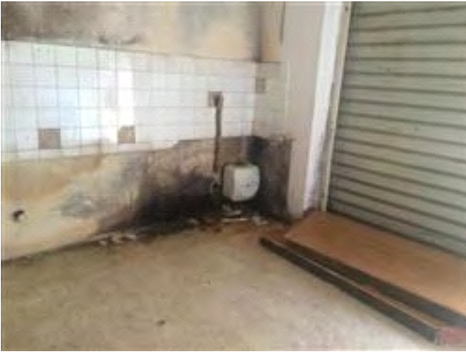
Vista interna - lato strada
