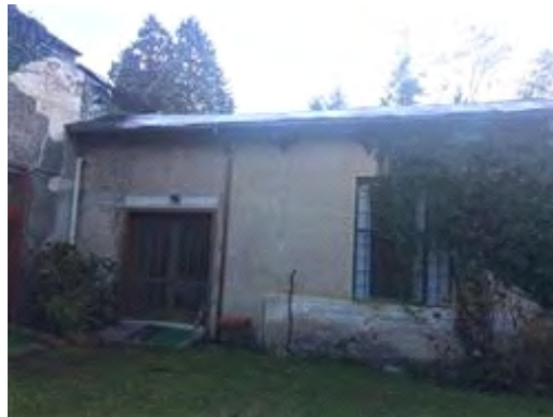
Vista esterna - zona nord
