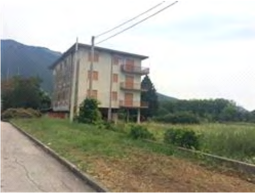
Vista Esterna intero edificio
