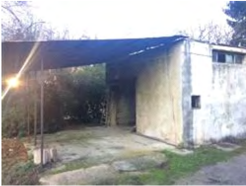
Vista esterna - Centrale Termica - Tettoia
