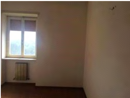
Vista interna - camera
