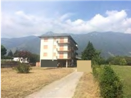
Vista Esterna intero edificio
