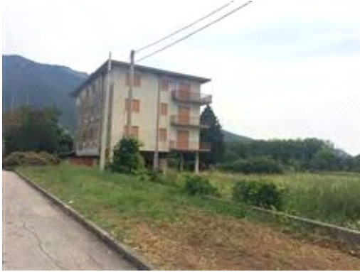
Vista Esterna intero edificio
