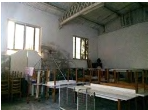
Vista interna - magazzino/deposito
