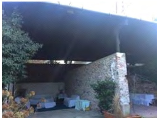
Vista esterna - portici/magazzino
