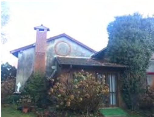
Vista esterna - lato ovest
