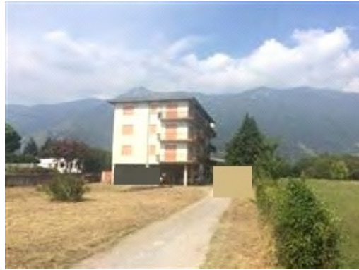
Vista Esterna intero edificio
