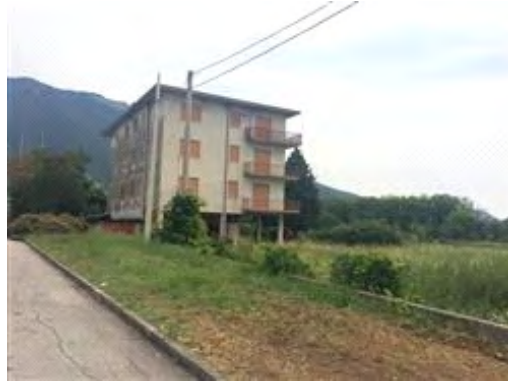
Vista Esterna intero edificio
