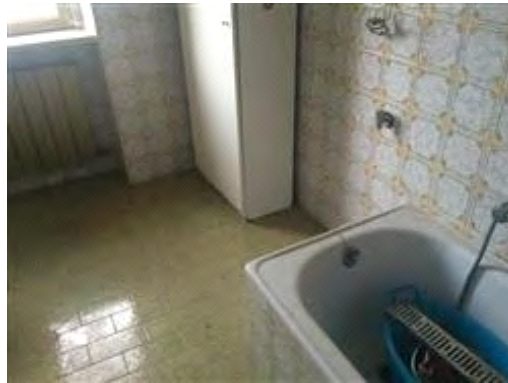
Vista interna - bagno
