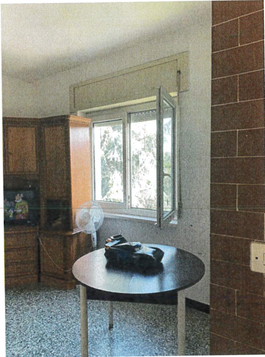
Particolare finestra in soggiorno sub. 5
