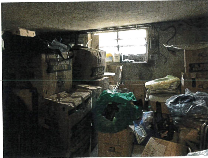
Interno box sub.2 impianto elettrico
