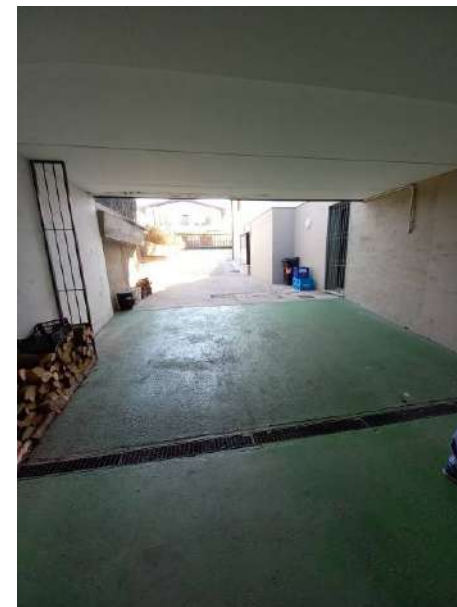
VISTA AUTORIMESSA P.INT
