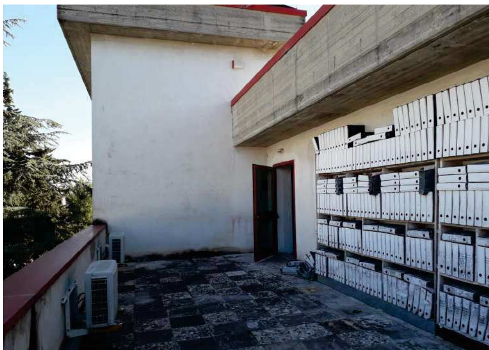
terrazzo piano primo lato nord corpo edilizio A- particolare esterno vialetto carrabile di raccordo con il piazzale interno lato nord.
