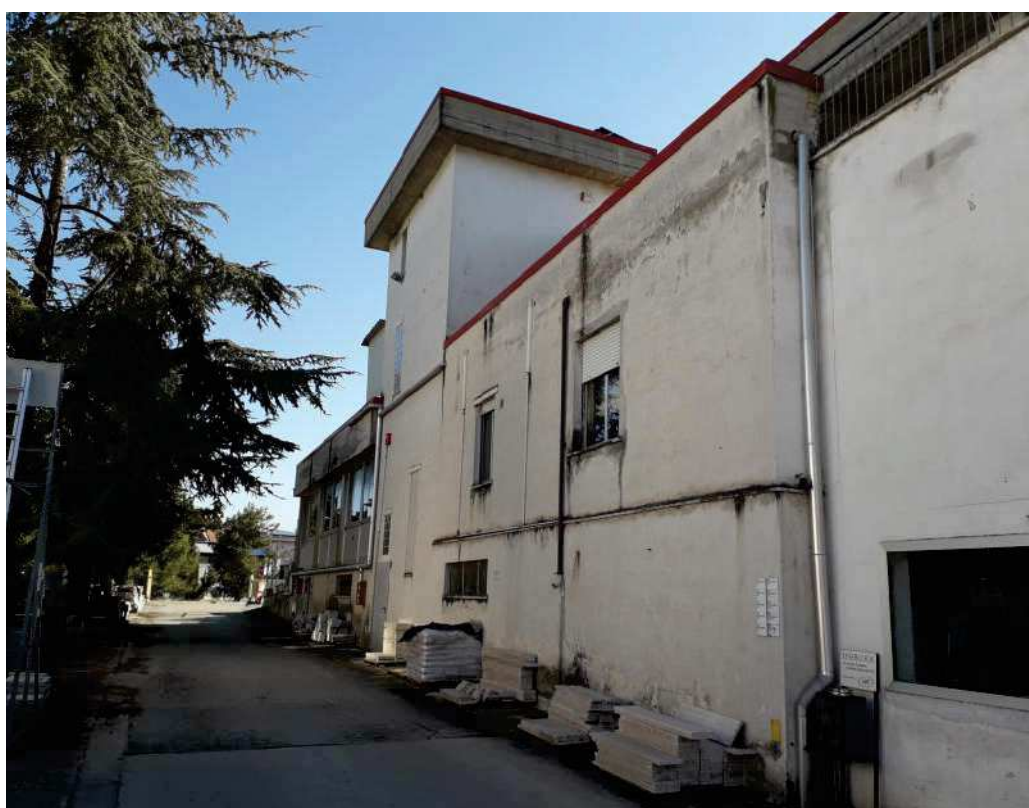
fronte nord corpo edilizio A sub 4
