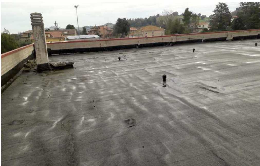
lastrico di copertura corpo edilizio A
