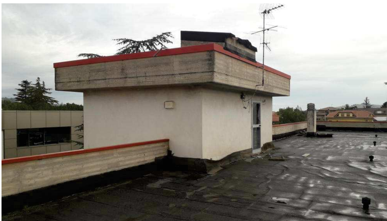
lastrico di copertura corpo edilizio A- blocco scala
