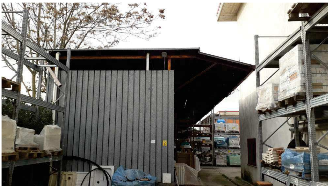
Accessorio C1 blocco magazzino struttura in ferro e tamponatura in lamiera zincata
