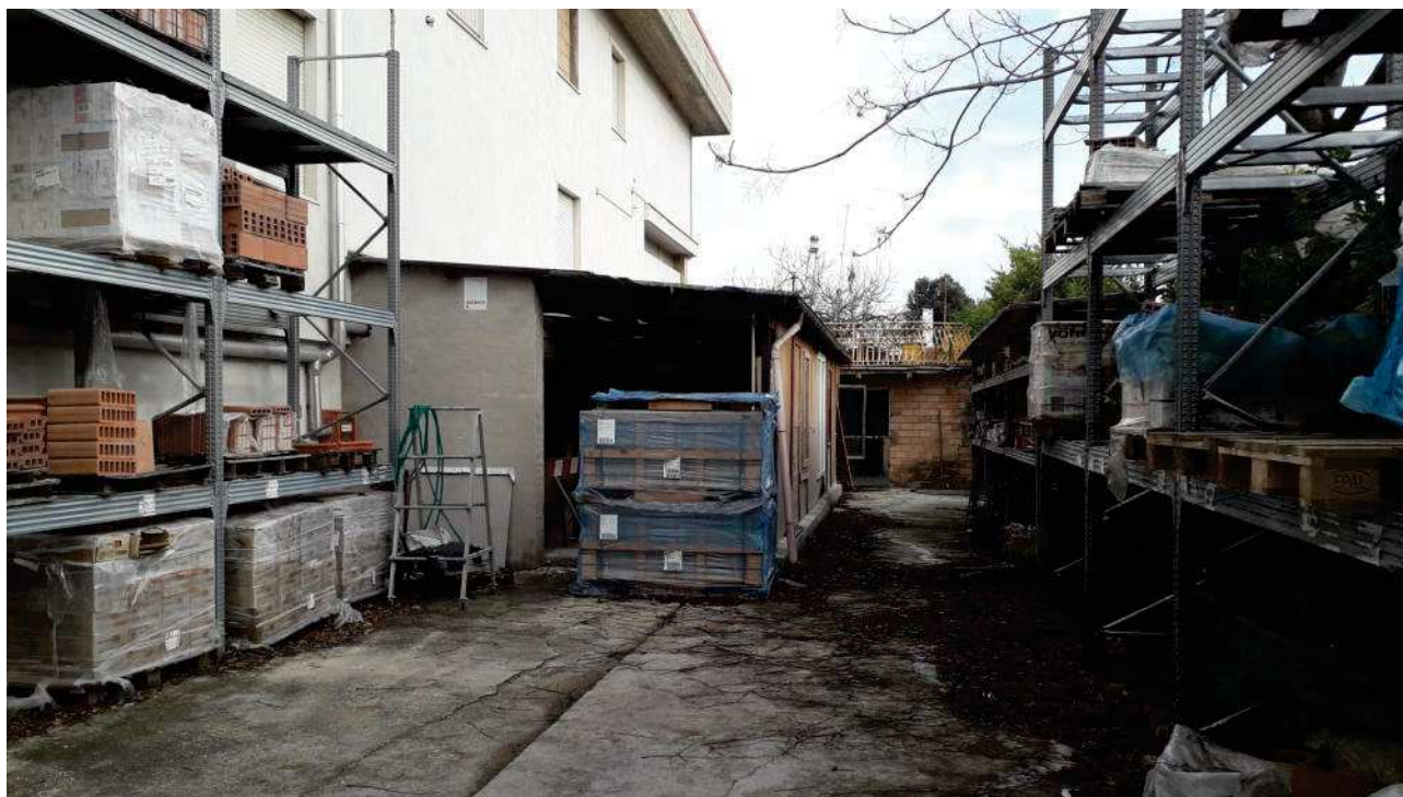
accessorio C2 adiacente al prospetto sud del corpo edilizio A - autorizzata come tettoia aperta .
