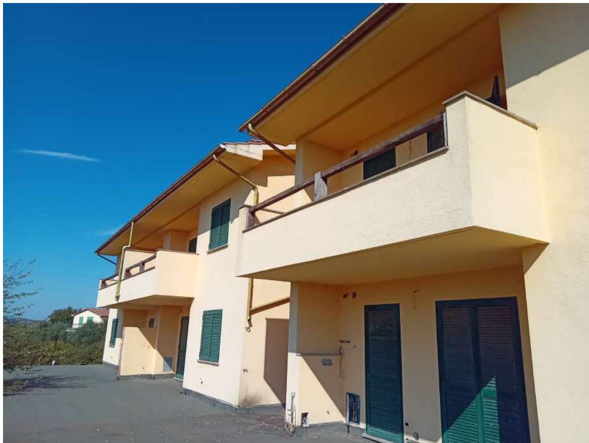
LOTTO 3 - Prospetto ovest
