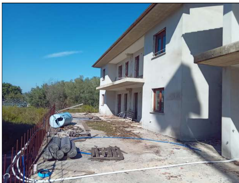
LOTTO 1- Prospetto ovest
