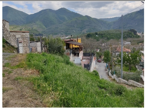
Foto 12 – Vista lato nord
