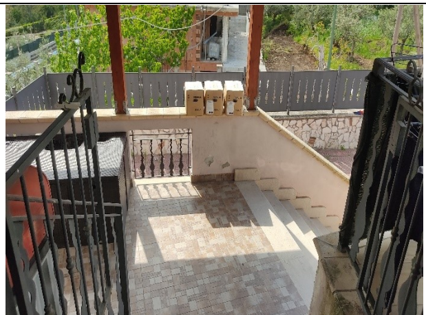
Foto 8 – Vista scala di accesso
