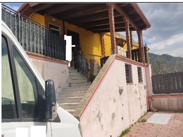
Foto 3 – Particolare della scala e tettoia coperta
