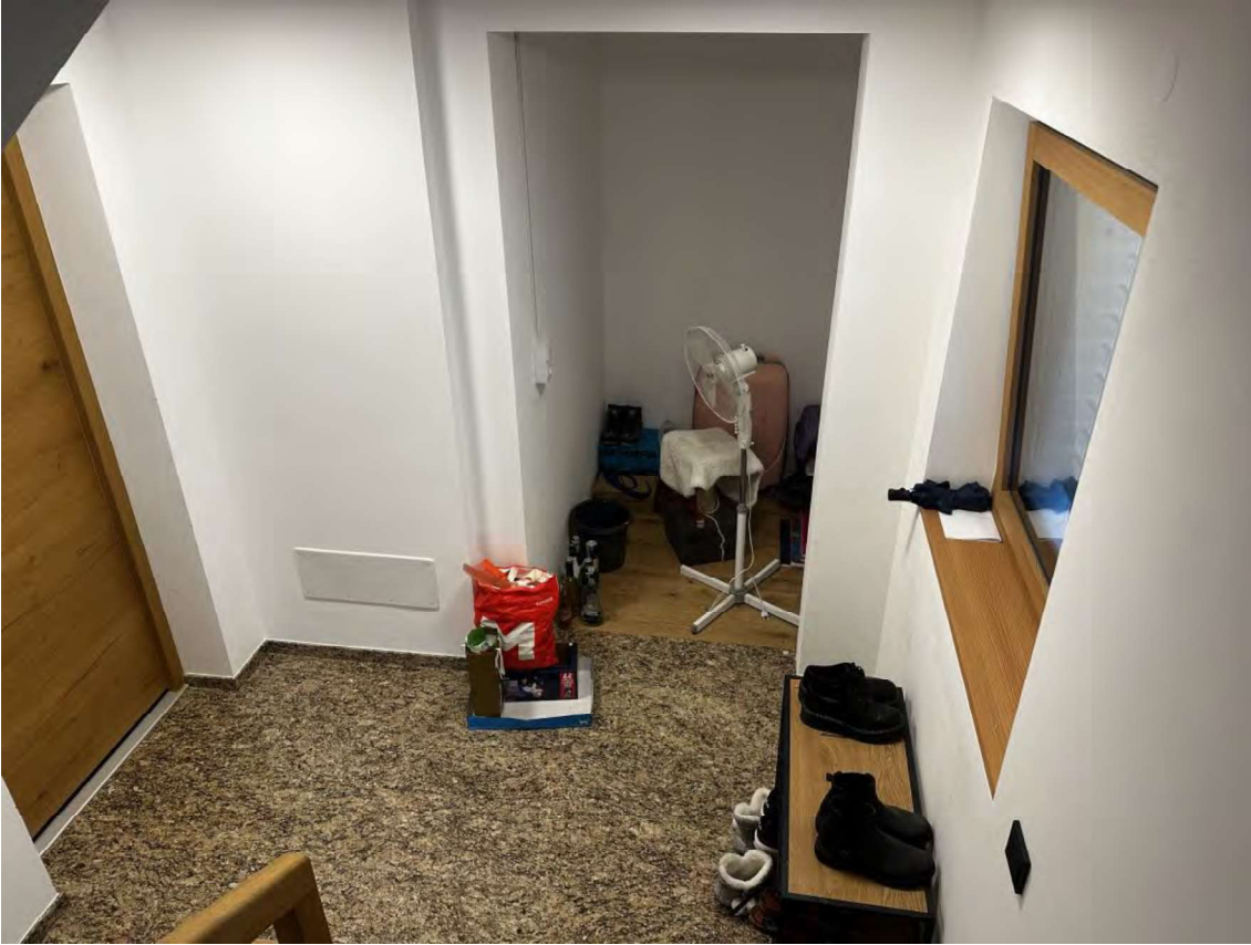
Vano scala con predisposizione vano ascensore
