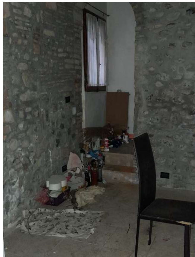
vano cucina-vista scala
