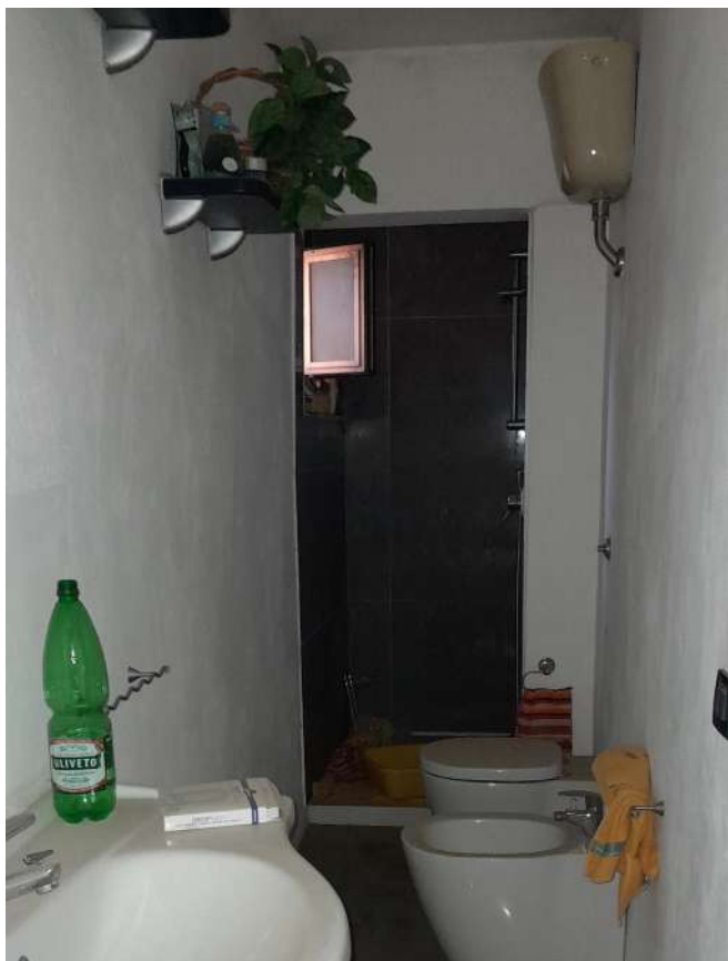
servizio igienico p.1.-vista doccia
