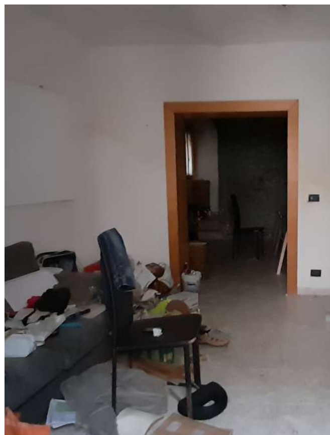
vano ingresso-soggiorno vista cucina
