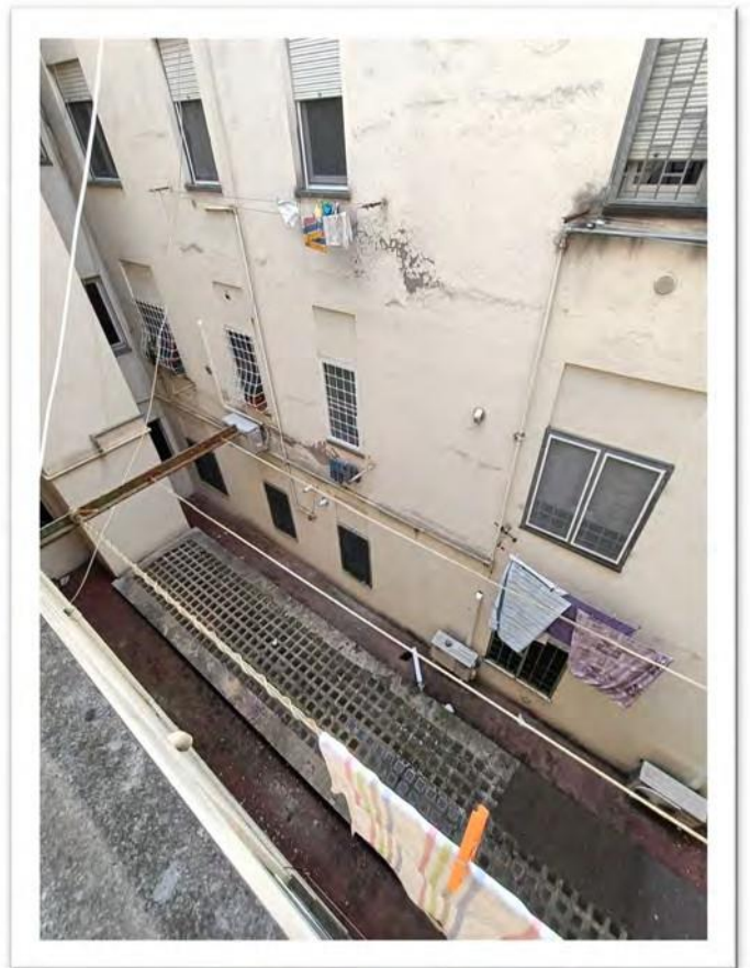
Vista della chiostrina dalla cucina e dal bagno
