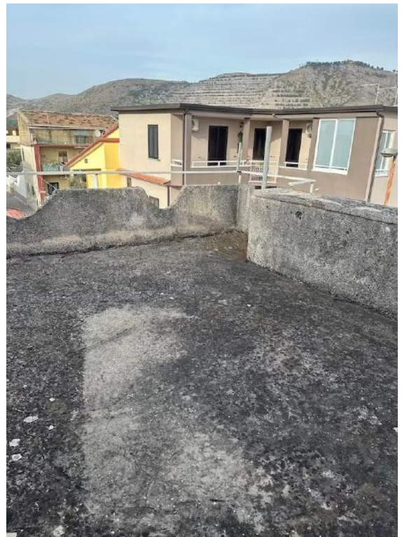
Foto n.11 – particolare terrazza scoperta
