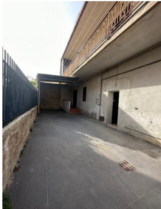
Foto n.3 – particolare corte d'accesso
