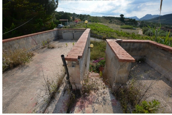
Foto 15 – Lastrico solare di 1° piano
