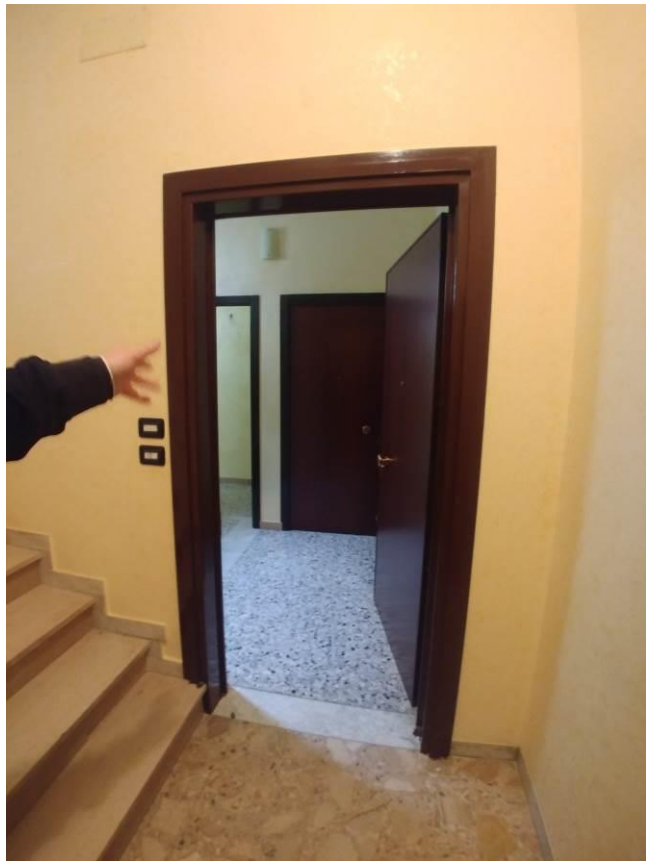
Figura 9: scalinata condominiale di accesso all'appartamento
