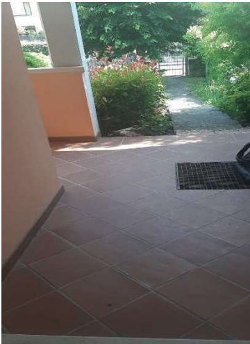
3 – Portico di ingresso
