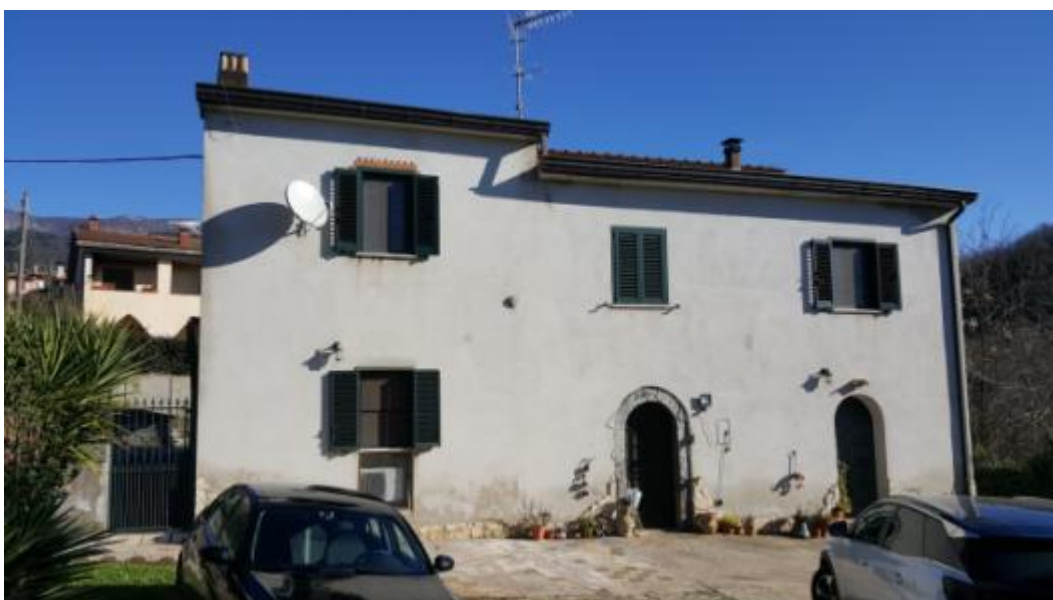
FOTO N°3 prospetto su ingresso dalla corte interna
