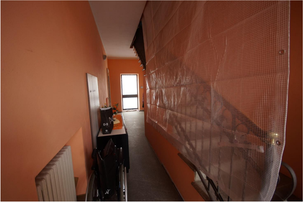
Interno vano scala piano terra
