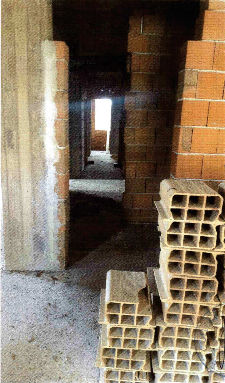
FOTO N° 4 – PARTICOLARE DI INTERNO
