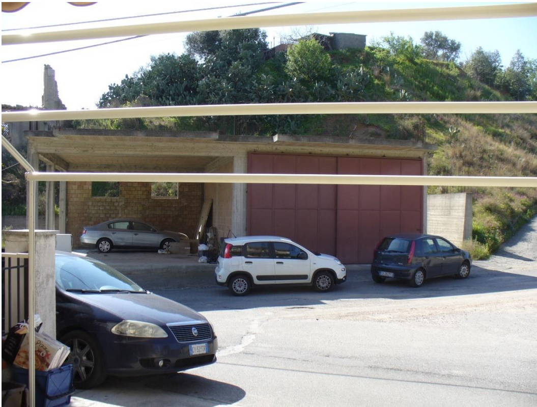
FOTO N. 18 – fabbricato in corso di costruzione fg 10 part. 5 -
