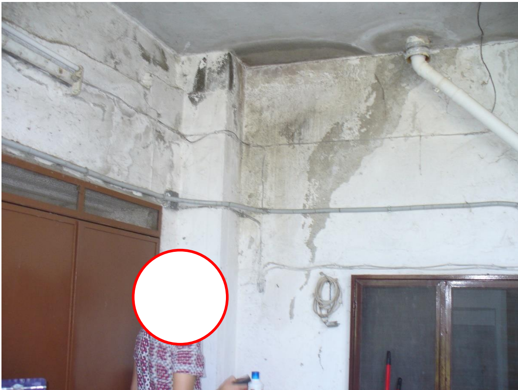
FOTO N. 16 – locale di sgombero-
