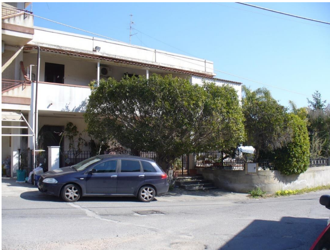
AEROFOTO N. 4 -prospetto su via Fossecali –
