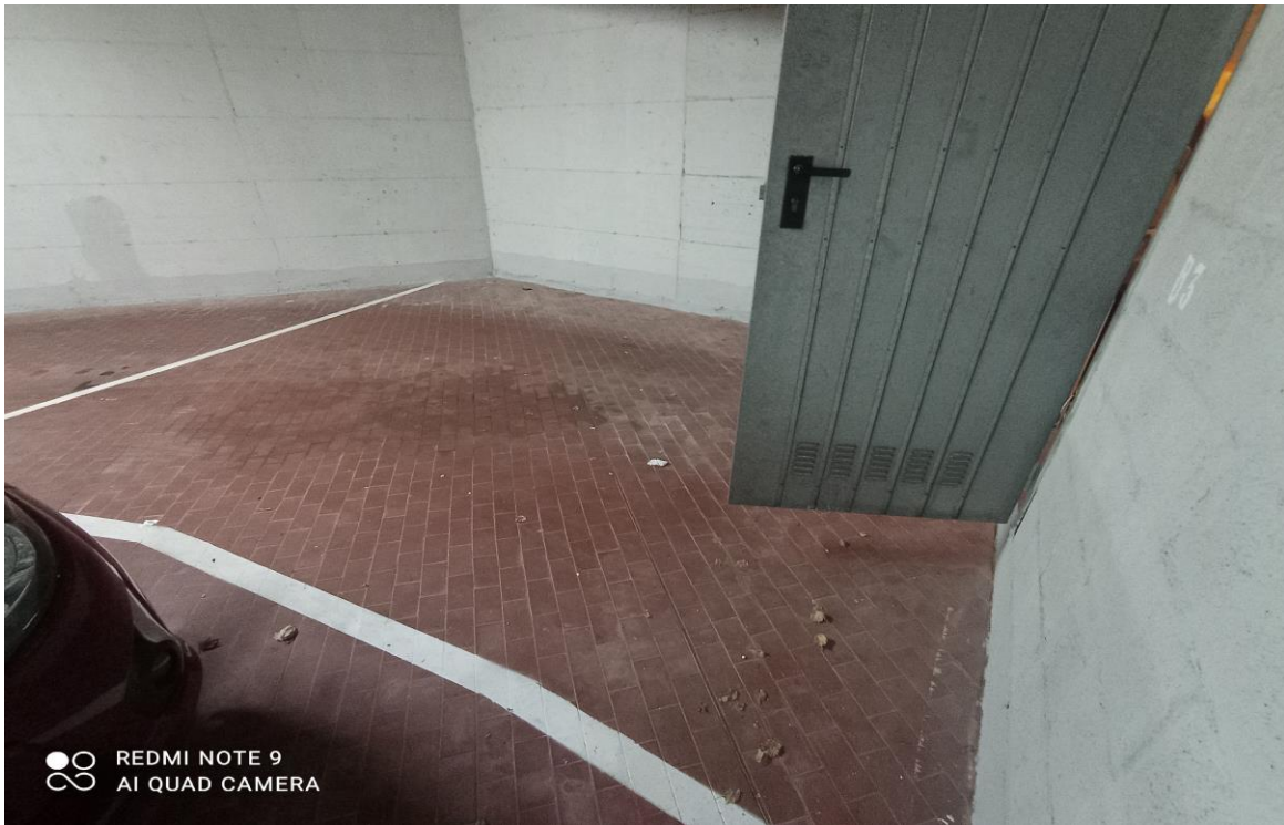
Vista Posto auto (coperto)
