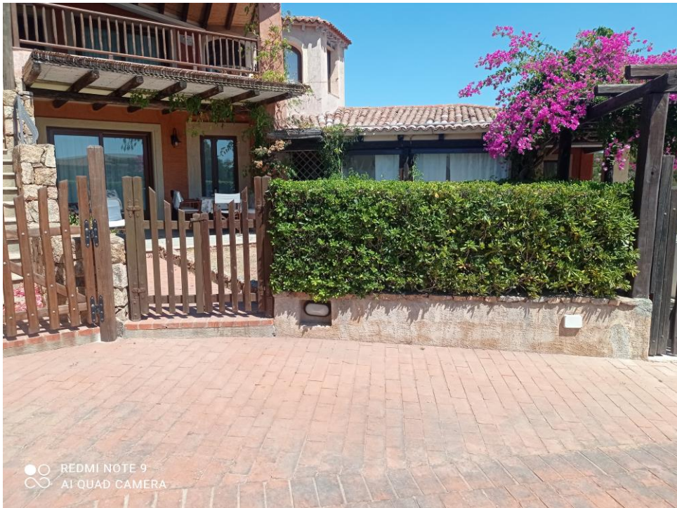
Vista Prospetto Principale
