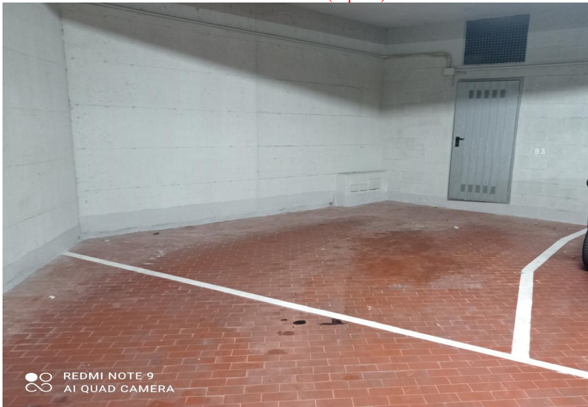
Vista Posto auto (coperto)
