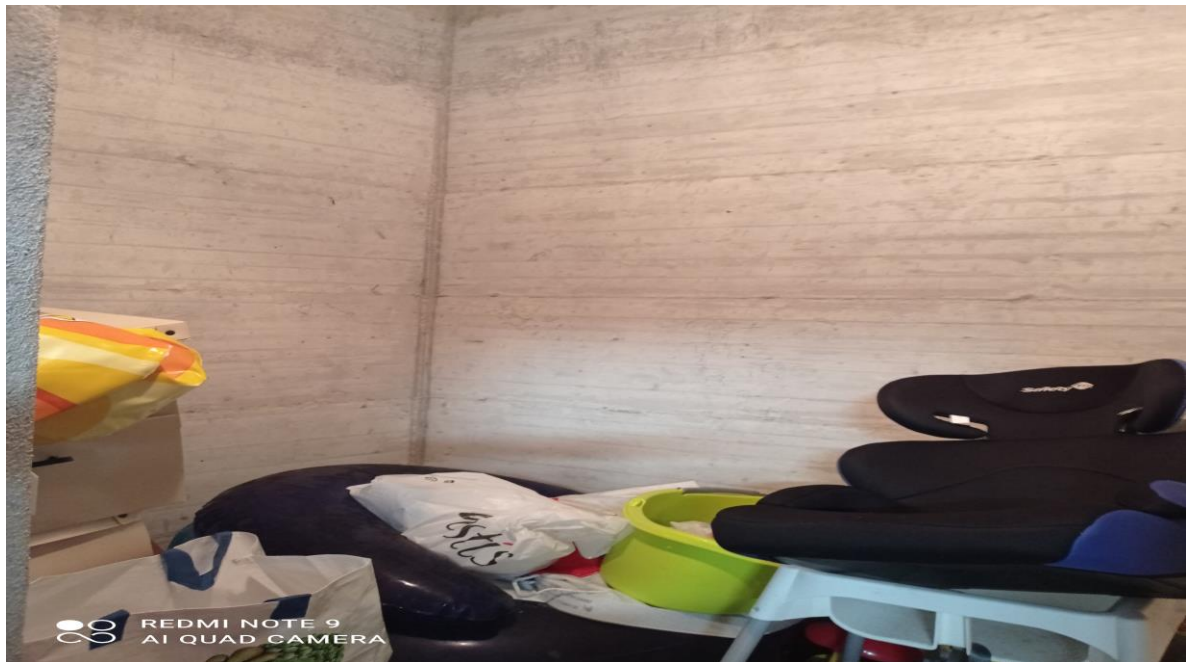
Vista Ambiente Cantina (Piano Interrato)
