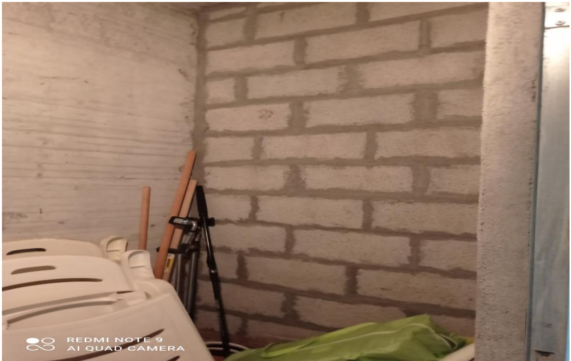
Vista Ambiente Cantina (Piano Interrato)
