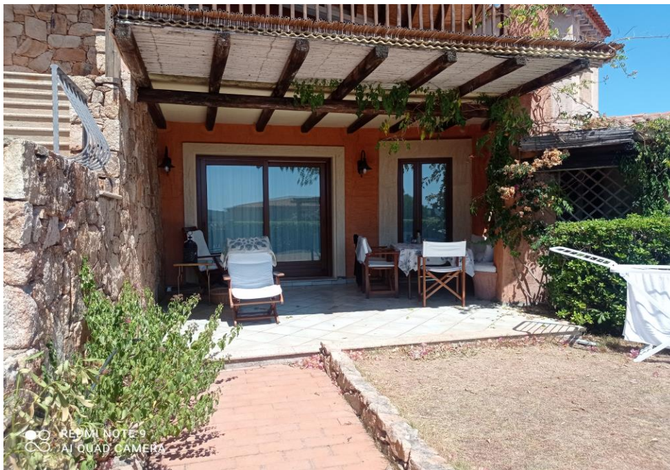
Vista Prospetto Principale
