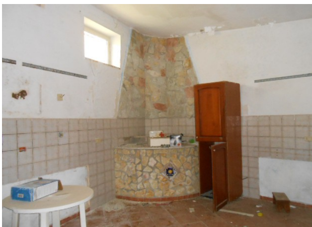
21. Ampliamento Nord-Ovest, interno
