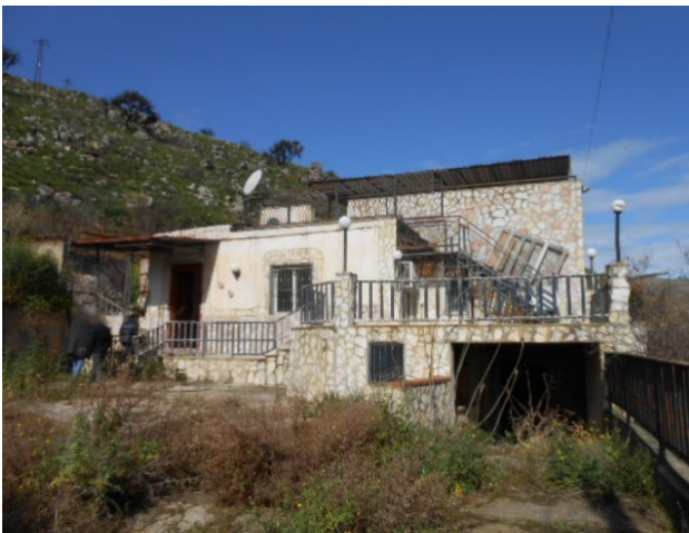
1. Prospetto Sud visto dall'interno della corte
