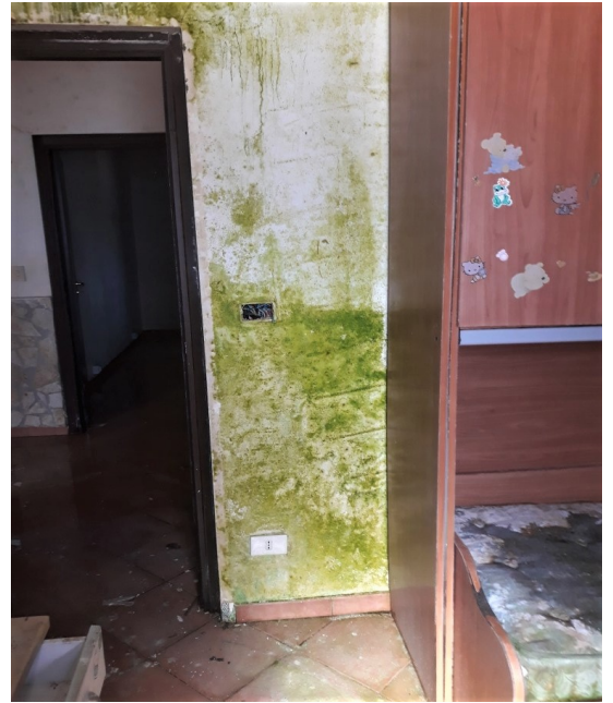
8. Villino originario. Diffuse muffe umide nelle pareti
