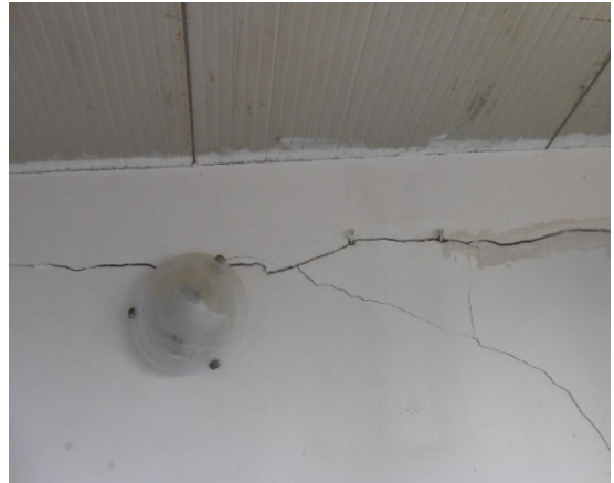
16. Ampliamento lato Nord, grave frattura macroscopica
