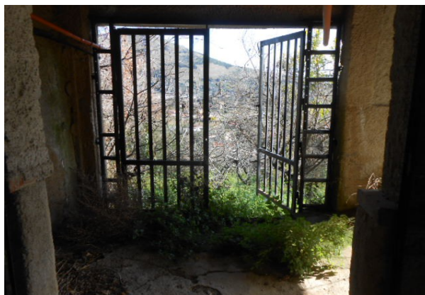
25. Piano sottostrada, il vuoto strutturale, il cancello che immette al terreno part. 1093.
