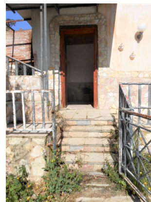
4. Il portoncino d'ingresso dalla corte
