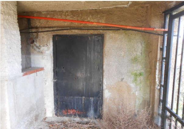
23. Piano sottostrada, il vuoto strutturale, la porta (bloccata) del magazzino o deposito/cantina
