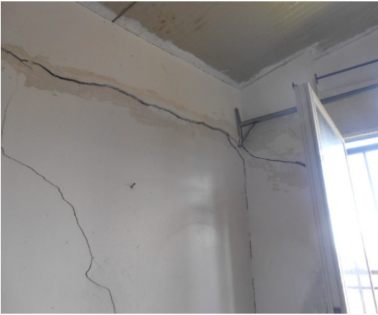
15. Ampliamento lato Nord-Est, gravi fratture macroscopiche diffuse
