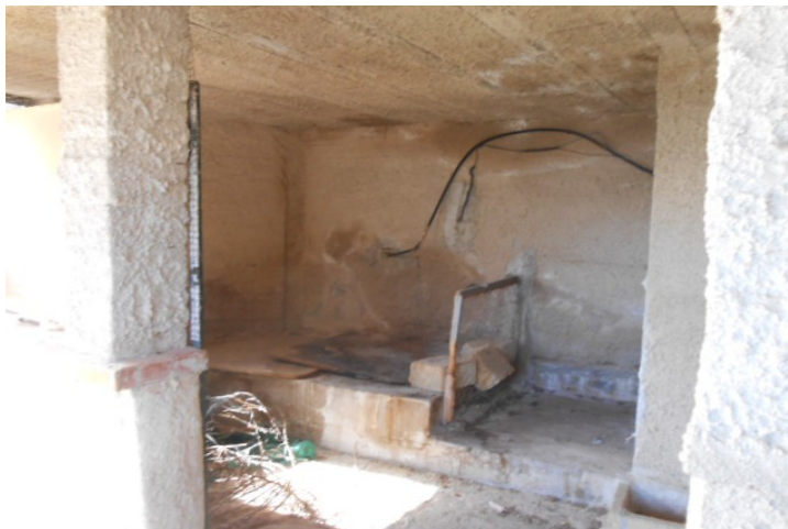
24. Piano sottostrada, il vuoto strutturale
