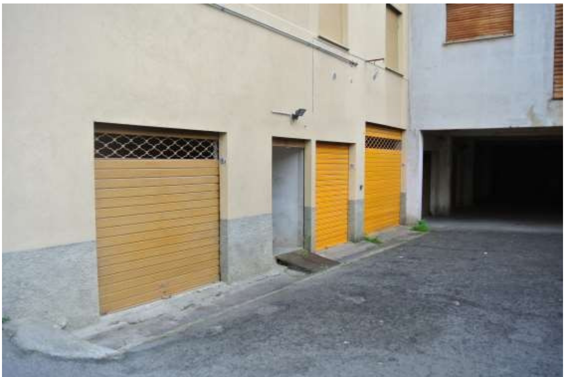
FOTO 20—cortile di accesso al locale cantine
