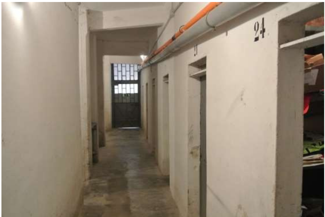
FOTO 18—corridoio comune cantine al piano seminterrato
