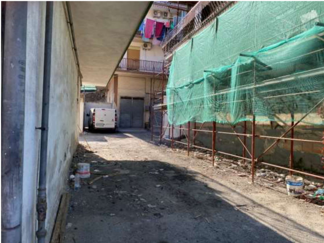
Foto 36 – Corsia di manovra ai garage
